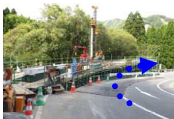
写真-8 施工状況
