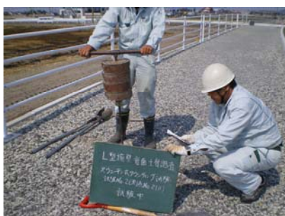
写真-1 試験状況写真
