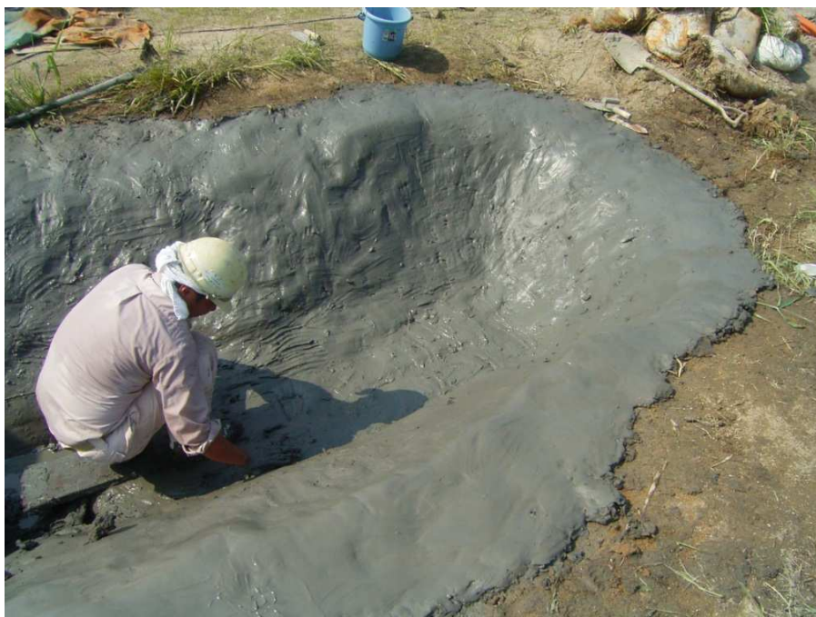
①トレンチ埋戻し状況(粘性土塗立て)
