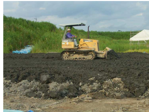
⑤セメント改良層 仮転圧
