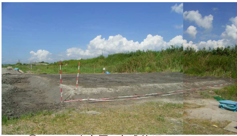
⑧セメント改良層 完成状況
