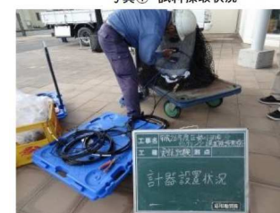
写真③計器設置状況
