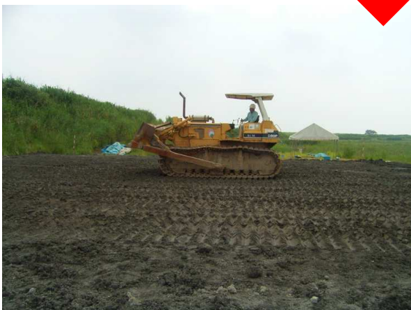
⑦セメント改良層 締固め
