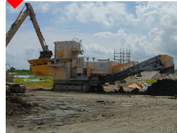
④セメント改良層 2次混合
