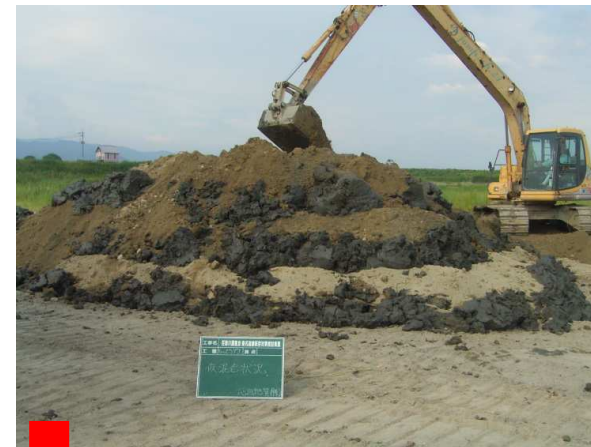
③セメント改良層 1次混合
