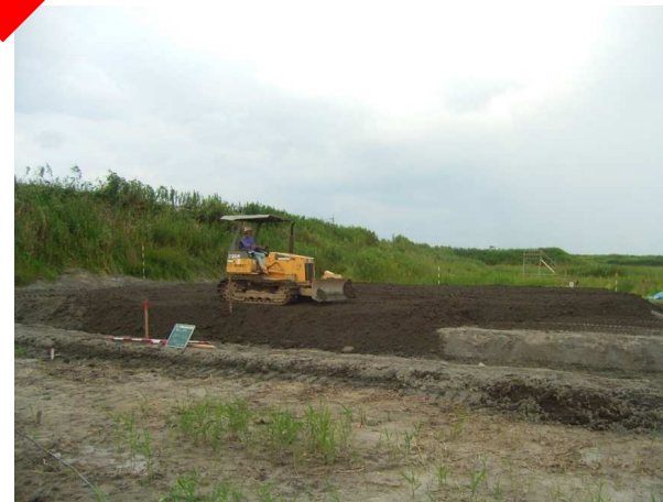
③覆土層 敷均し
