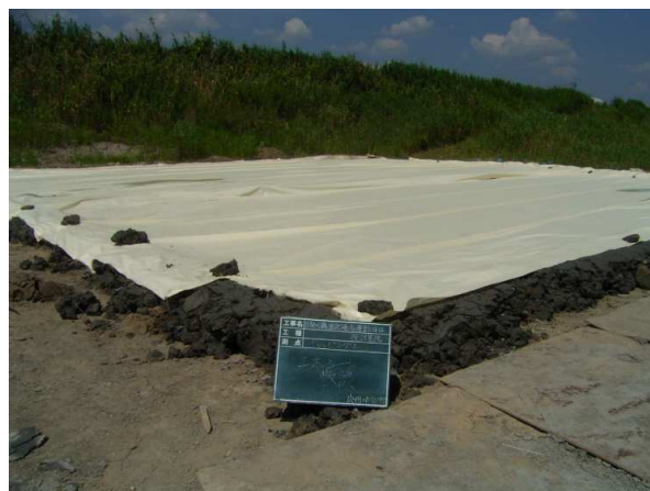
②土木シート敷設
