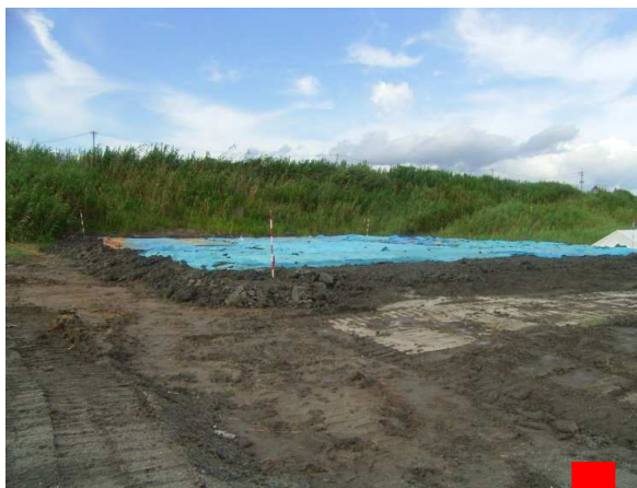
⑥セメント改良層 養生
