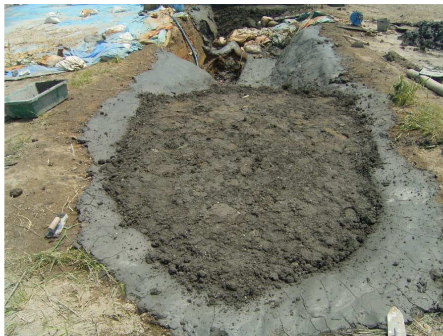
②トレンチ埋戻し状況(安定処理土投入)
