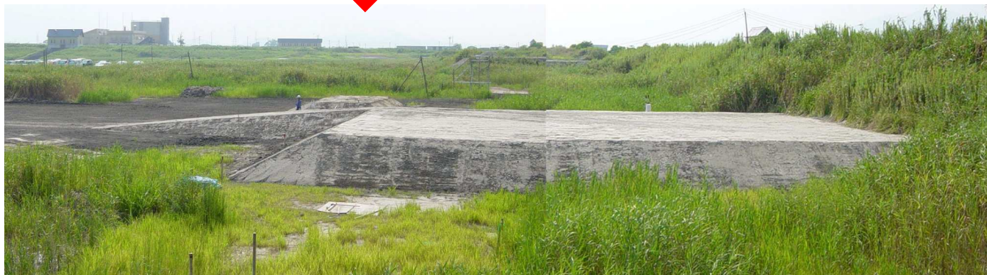
⑤キャッピング完成状況
