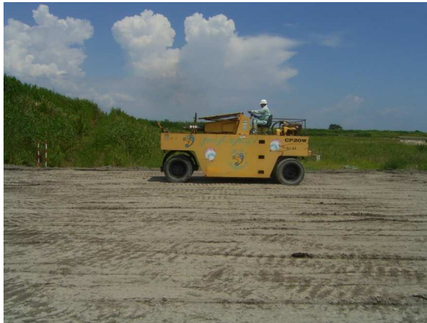
④覆土層 締固め
