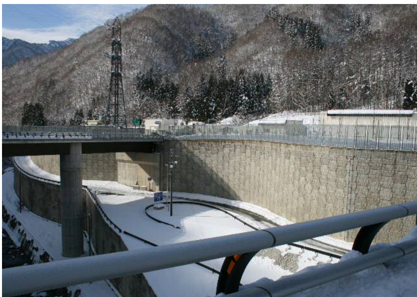
テールアルメ工法（2 段積み） 東海北陸道飛騨河合 PA（岐阜県）
