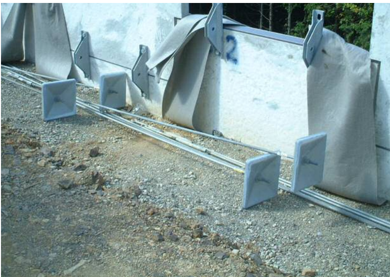
写真 1.2 アンカープレート及びタイバー
