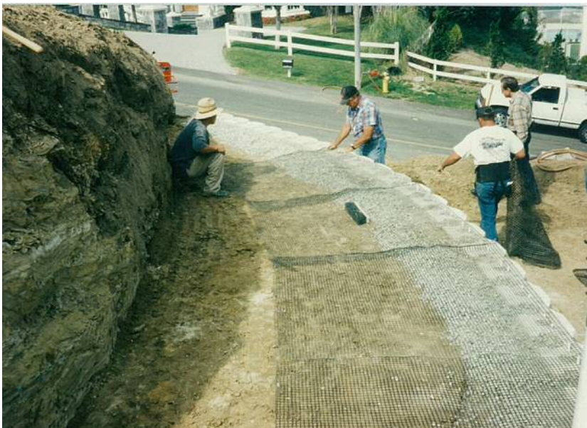
ジオテキスタイル補強土壁 (USA LA) 施工中
