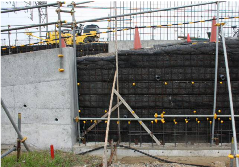
RRR 工法 近鉄奈良線（大阪府） 左側：完成後，右側：施工中
