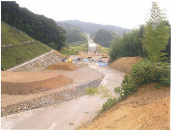
No. 739より起点側を望む
