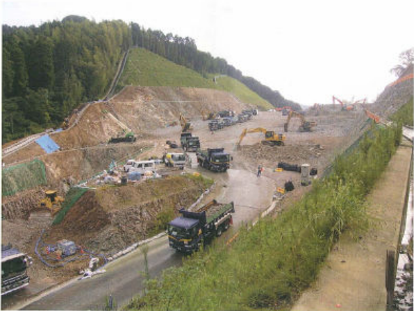
No. 749(左)より起点側を望む
