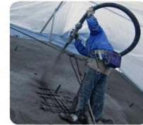
繊維補強モルタル吹付状況
