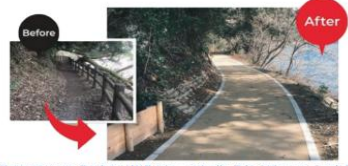
管理車両進入用 施工方法：材料敷き均し・不陸調整・敷水・振動ローラー転圧方式 使用量：1㎡あたり2.7袋（54kg/㎡） まき出し厚さ：35mm 仕上がり厚さ：30mm
