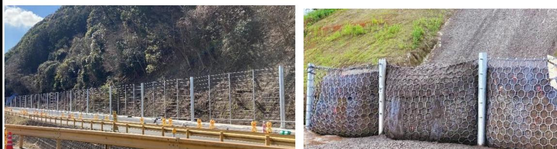
実物大実験を実施し、確実な土砂捕捉性能と部材変形特性を確認し、実験で得られた数値を基に設計を行っており安全性を担保できる。早期に復旧できる機能をもつ防護柵が今求められてこれらを解決すべく中空鋼管の着脱式二重管構造を用い開発・実用化したこうほうである。
