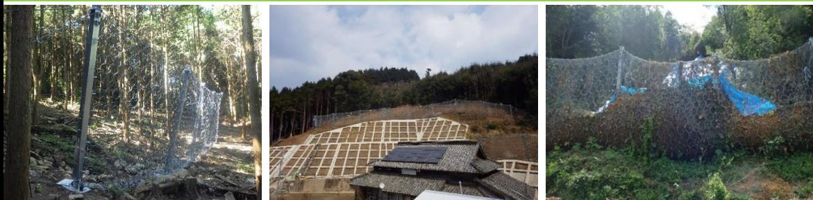
高強度ネット・ロープ・エネルギー吸収装置等がバランスよく変形することで、崩壊土砂を安全に捕捉することができる土砂防護の待ち受け工です。土工や基礎工が少なく、大掛かりな仮設を必要としない為、家屋などが隣接する場合などでも施工が可能となり、工事範囲の縮小、工期の大幅な短縮にも繋がります。
