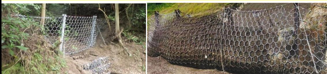
渓流に設置する土石流および流木の捕捉を目的とした柔構造の土石流・流木捕捉工であり、土石流荷重作用時にリングネットとエネルギー吸収装置のブレーキリングが変形することで大きな衝撃エネルギーを吸収できる柔構造物工法である。
