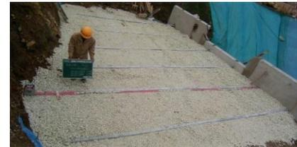
補強土壁との併用によるの軽量盛土
