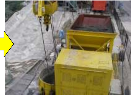
③ コンクリートバケット積込み
