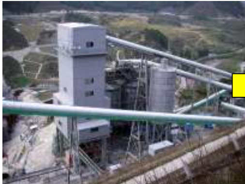
① コンクリート練混ぜ
