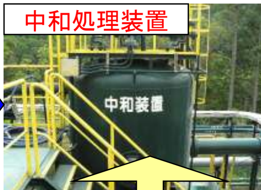
PH調整剤(炭酸ガス)注入
