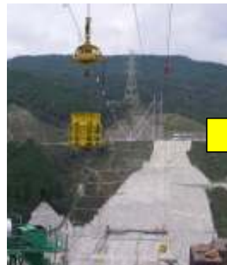
④ ケーブルクレーンでグラウンドホッパーまで運搬
