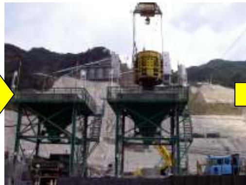
④ ケーブルクレーンでグラウンドホッパーまで運搬
