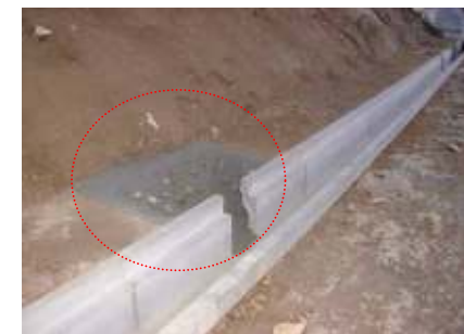
小動物の脱出経路の設置 (道路脇の側溝)
