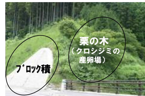
クロシジミの産卵木であるクリの保全 (一部ブロック積とし法勾配を立てる工法に変更)
