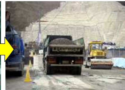
⑤ ダンプトラック積込み・運搬
