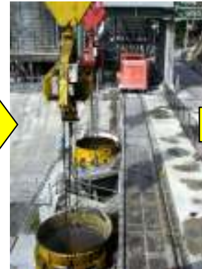
③ コンクリートバケット積込み
