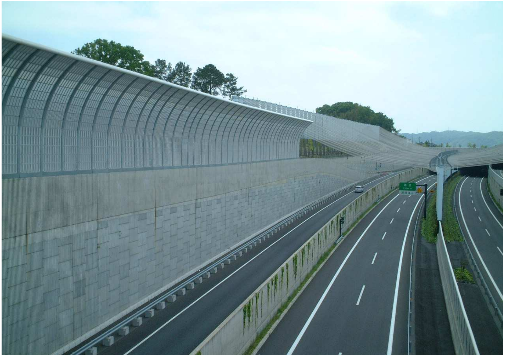
多数アンカー工法 第二京阪道路(大阪府)
