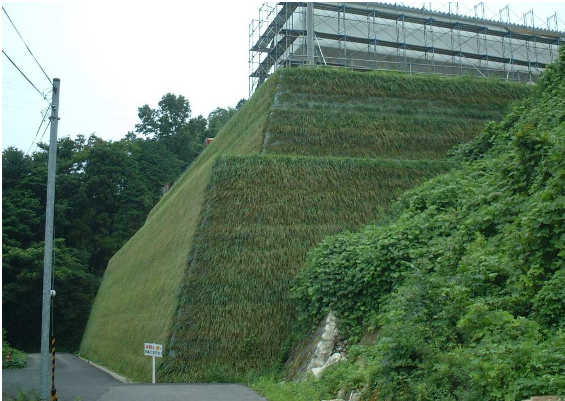
ジオテキスタイル補強土壁工法(テンサー)
