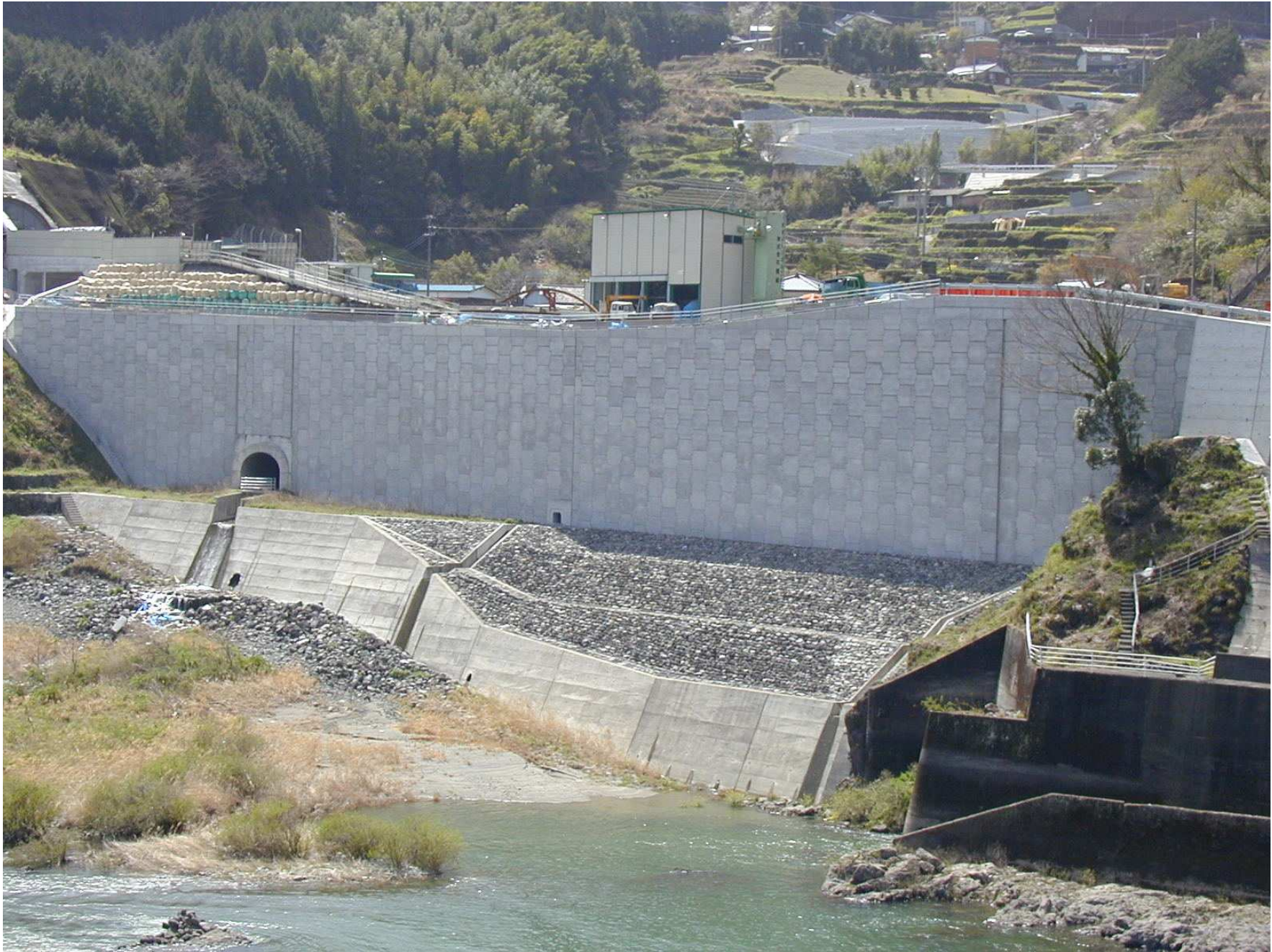
テールアルメ工法（高知県）
