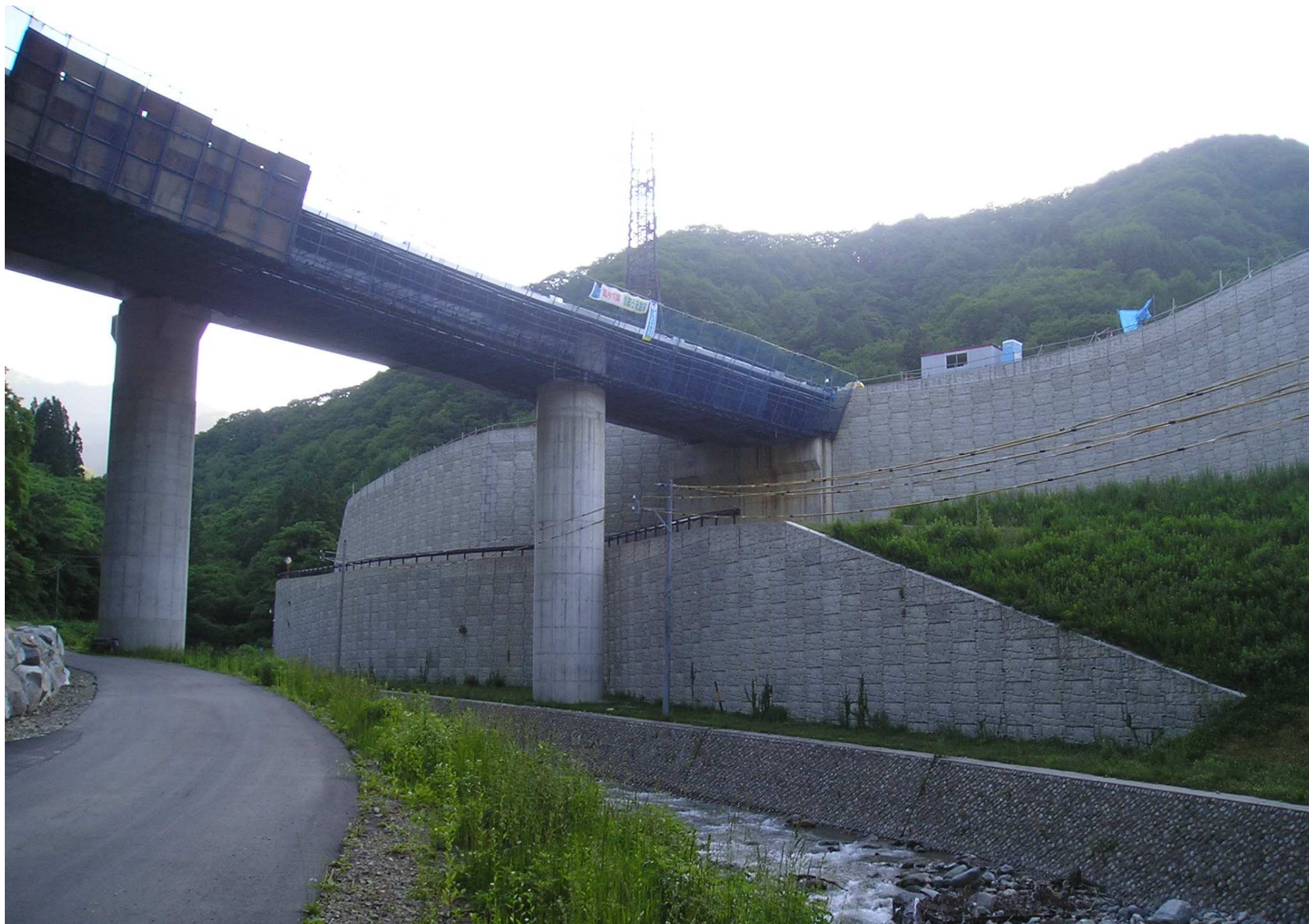
テールアルメ工法(2段積) 東海北陸道飛騨河合PA
