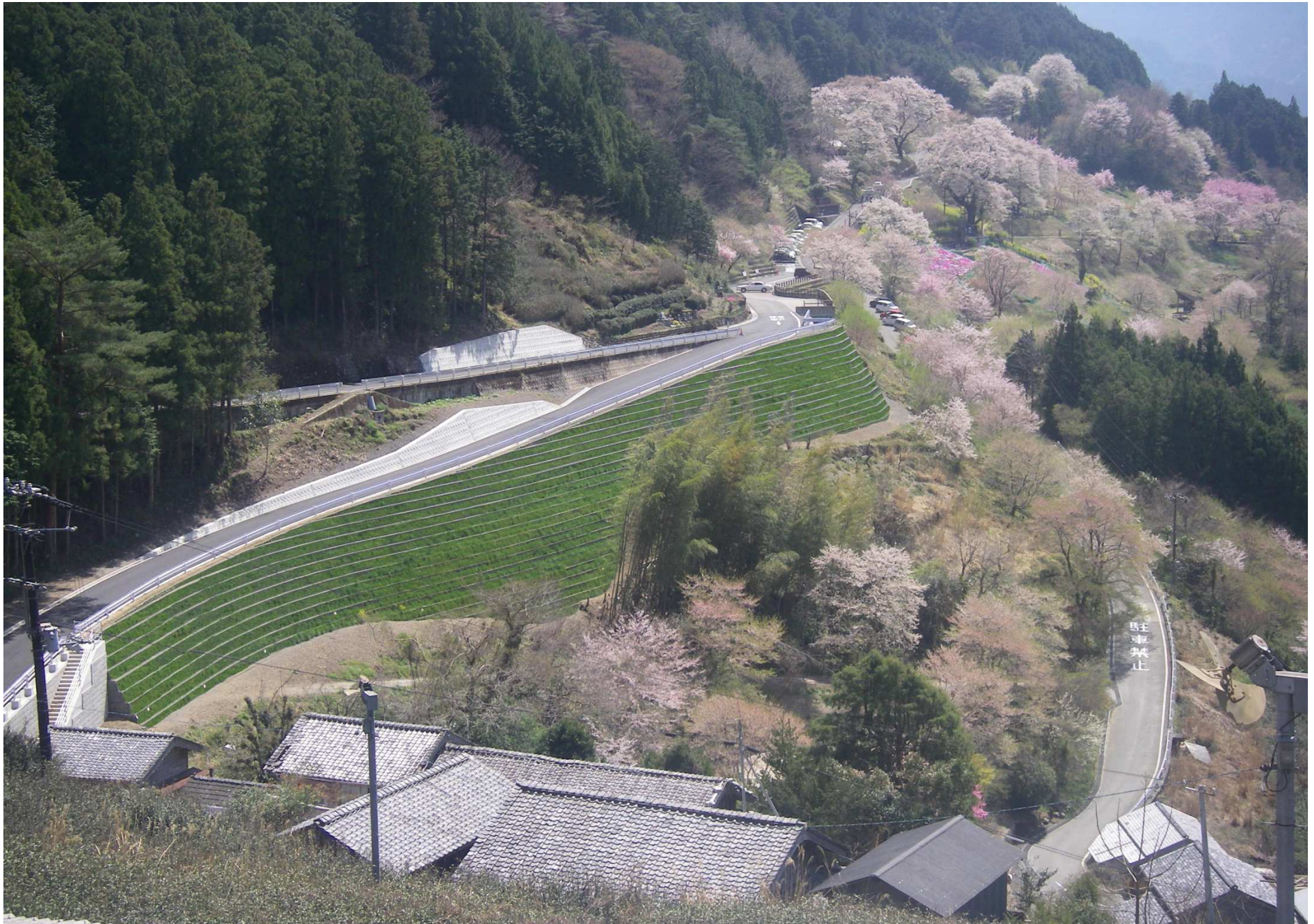
ジオテキスタイル補強土壁工法(アデム)
