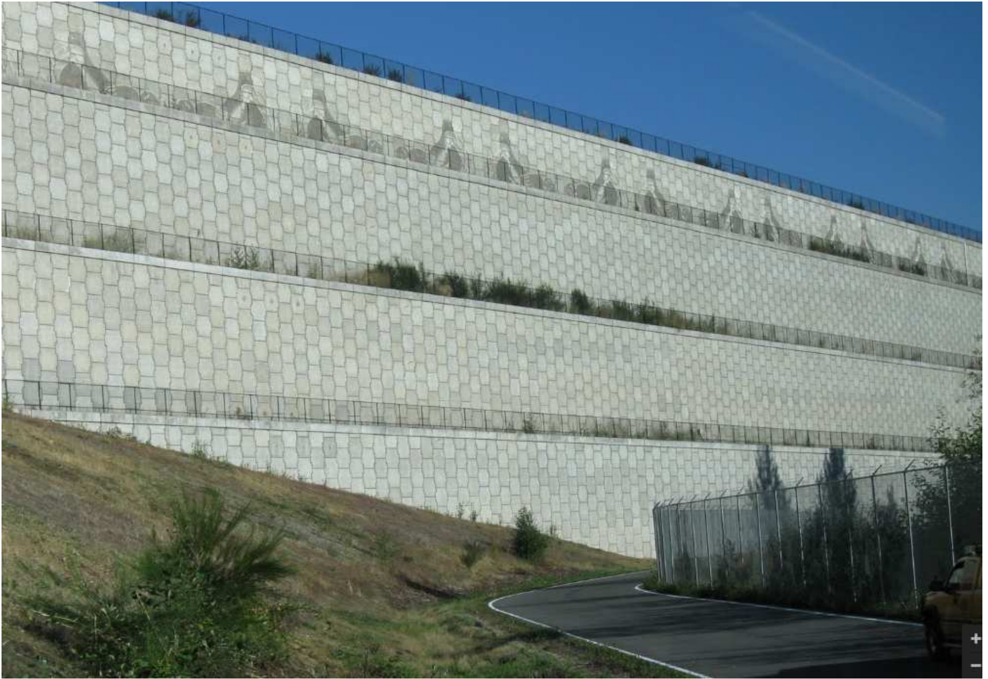
テールアルメ工法(アメリカ シアトル タコマ国際空港)
