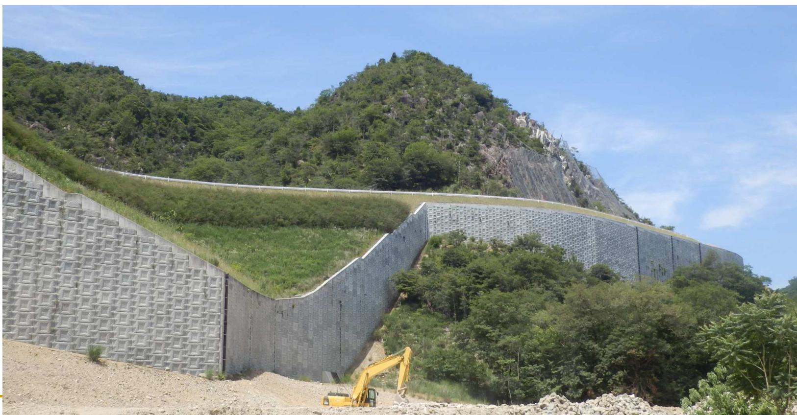
多数アンカー工法(岡山県)
