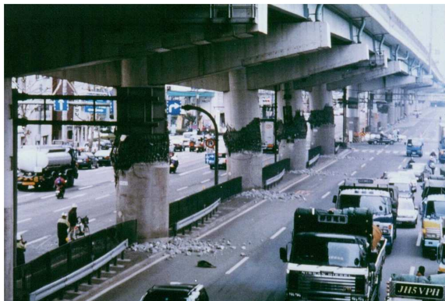
崩落の危険性
