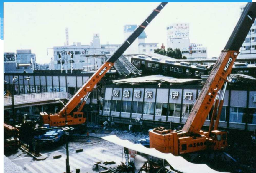
鉄道橋も崩落
