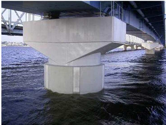
鉄筋コンクリート巻立て
