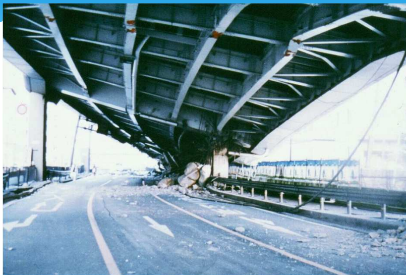
橋脚が完全破壊
