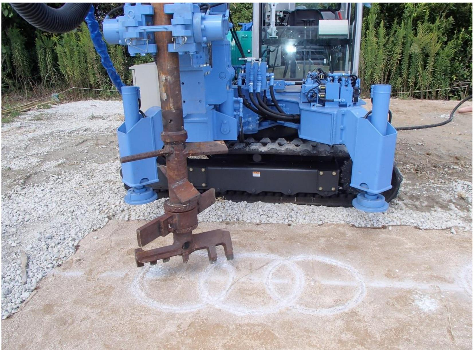
**改良杭工法を用いたスラグジオポリマー止水壁の作成試験(1)**
