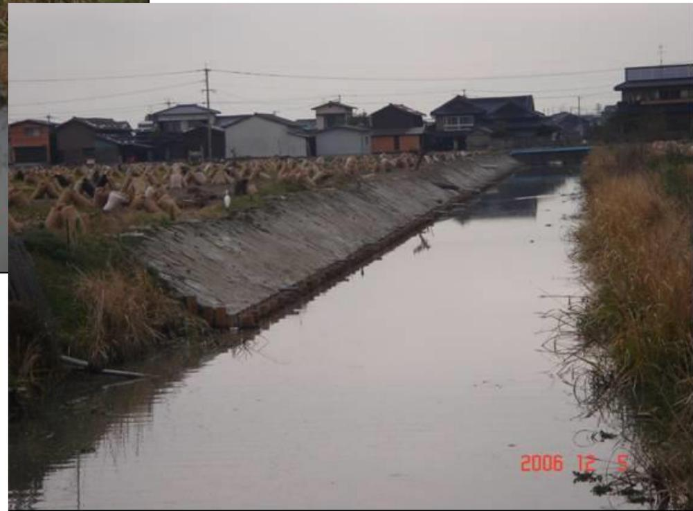
**杭柵工による崩壊クリーク法面の改修直後**
