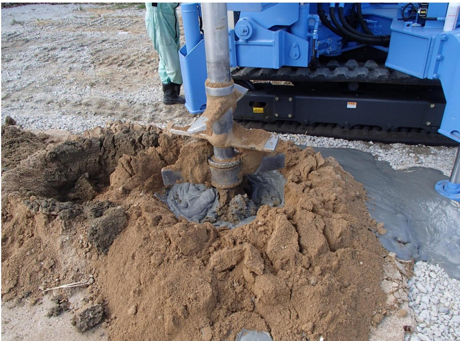
改良杭工法を用いたスラグジオポリマー止水壁の作成試験(2)
