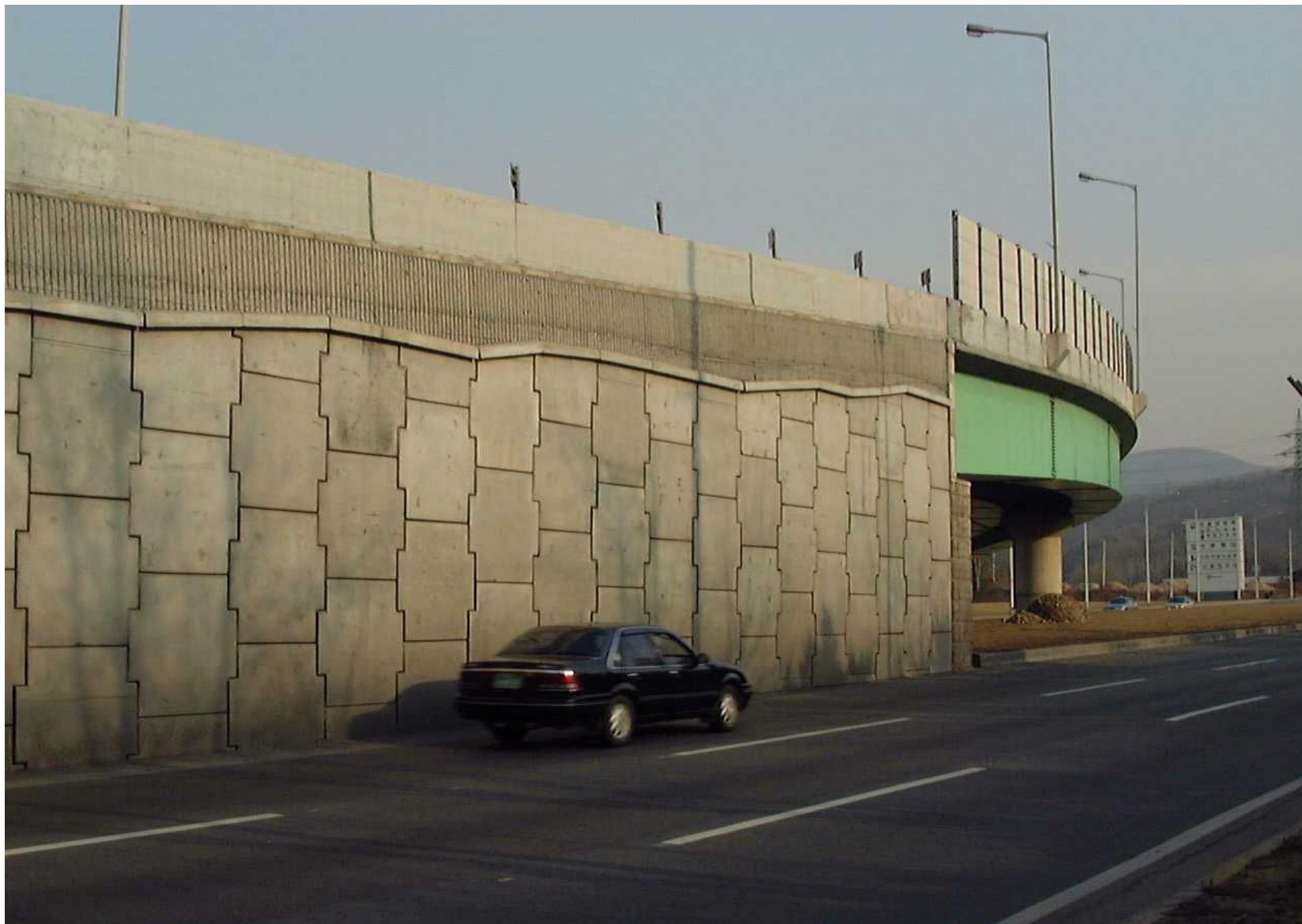
ジオテキスタイル補強土壁工法(韓国ソウル)
