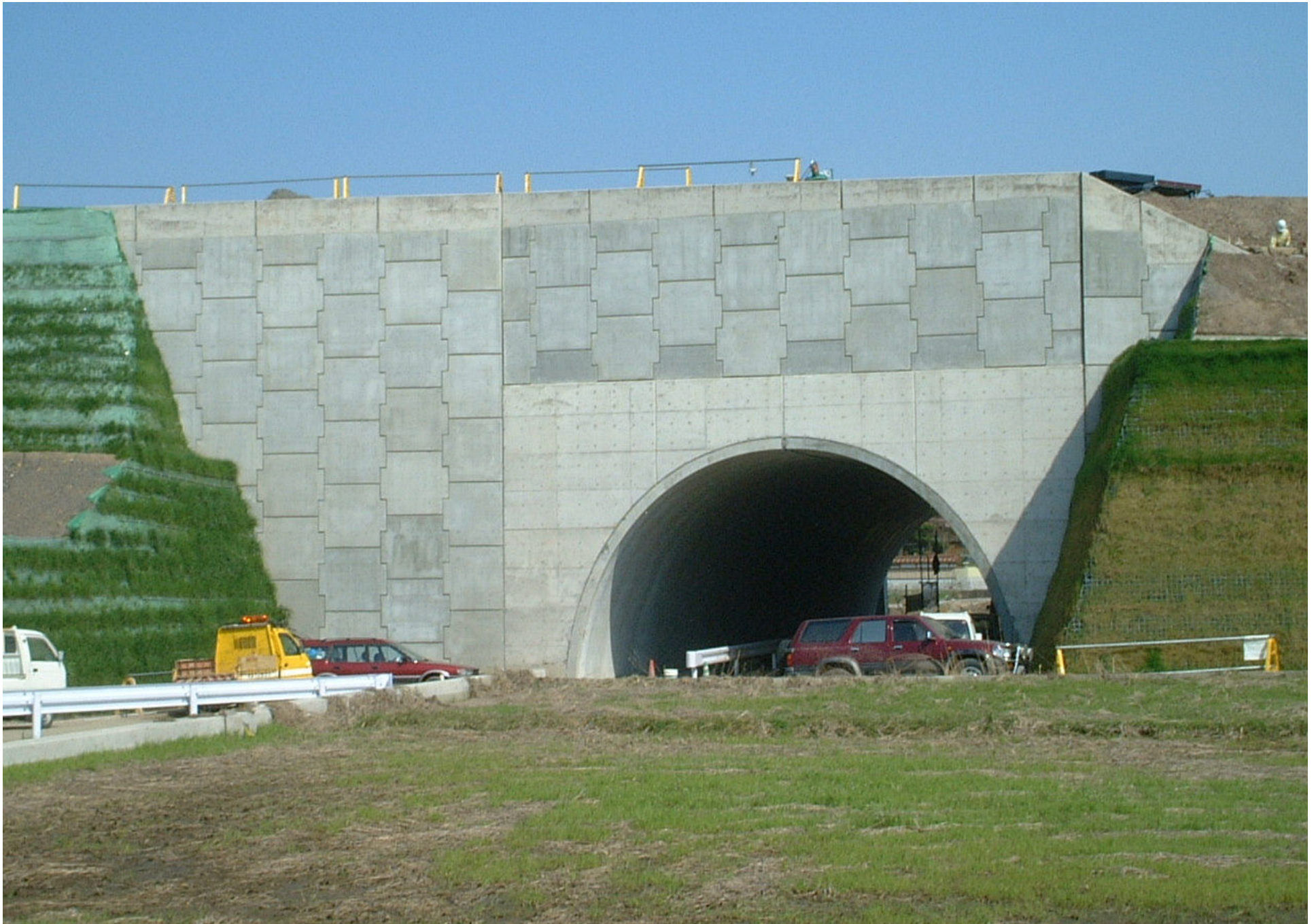
テールアルメ工法・カラーウォール・ジオテキスタイル補強土壁工法 鳥取自動車道(鳥取県)
