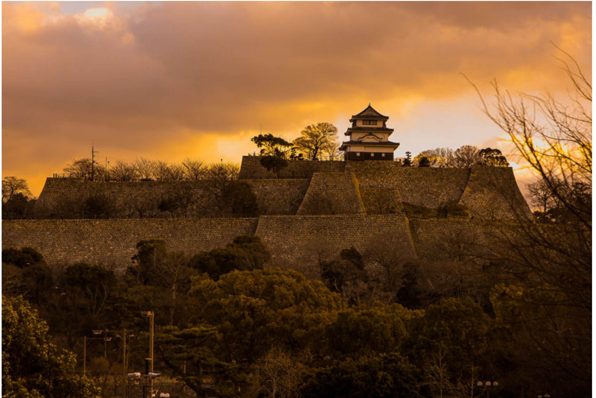
丸亀城 石垣(4段積み H=60m)(香川県)
