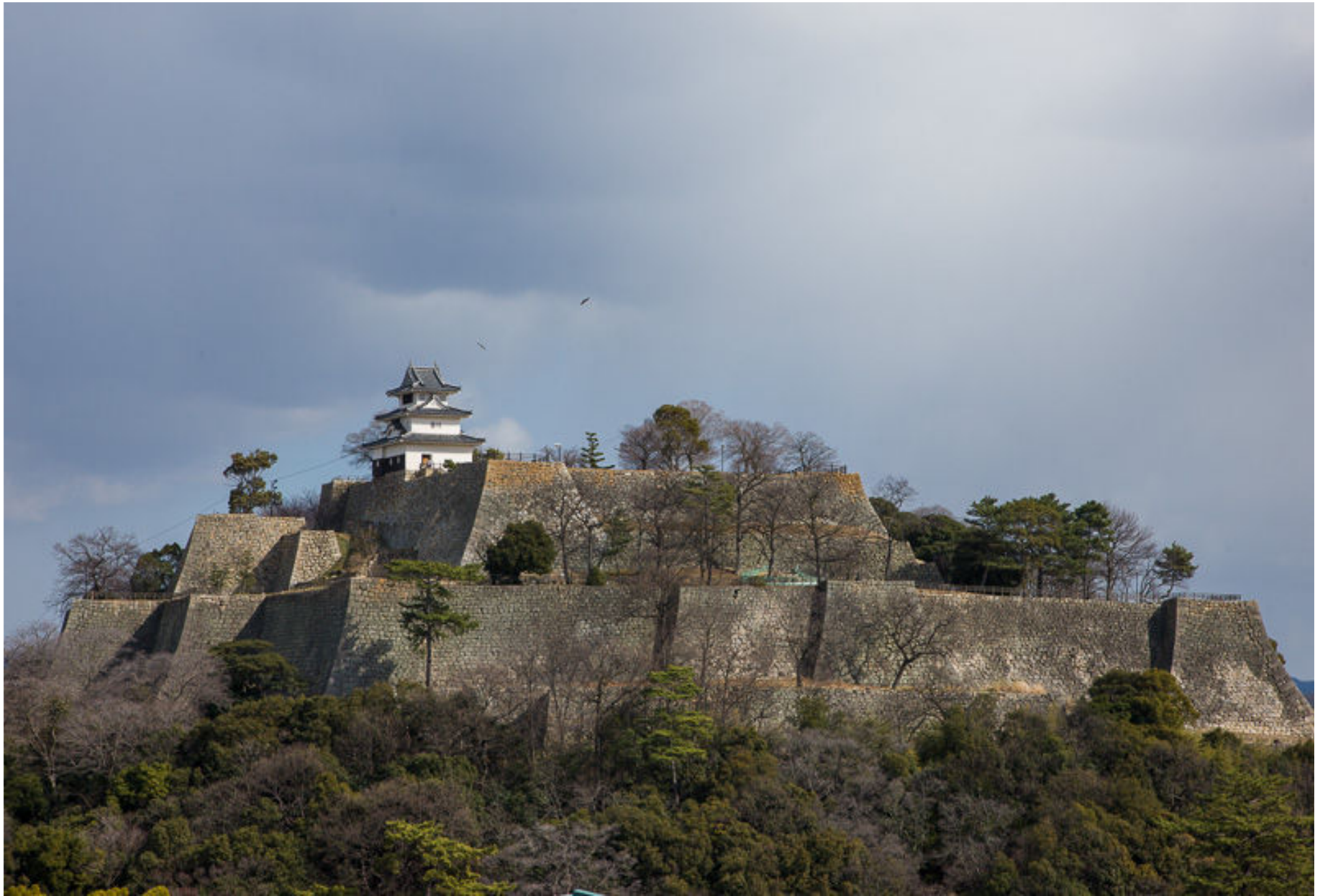
丸亀城 石垣(4段積み H=60m)(香川県)
