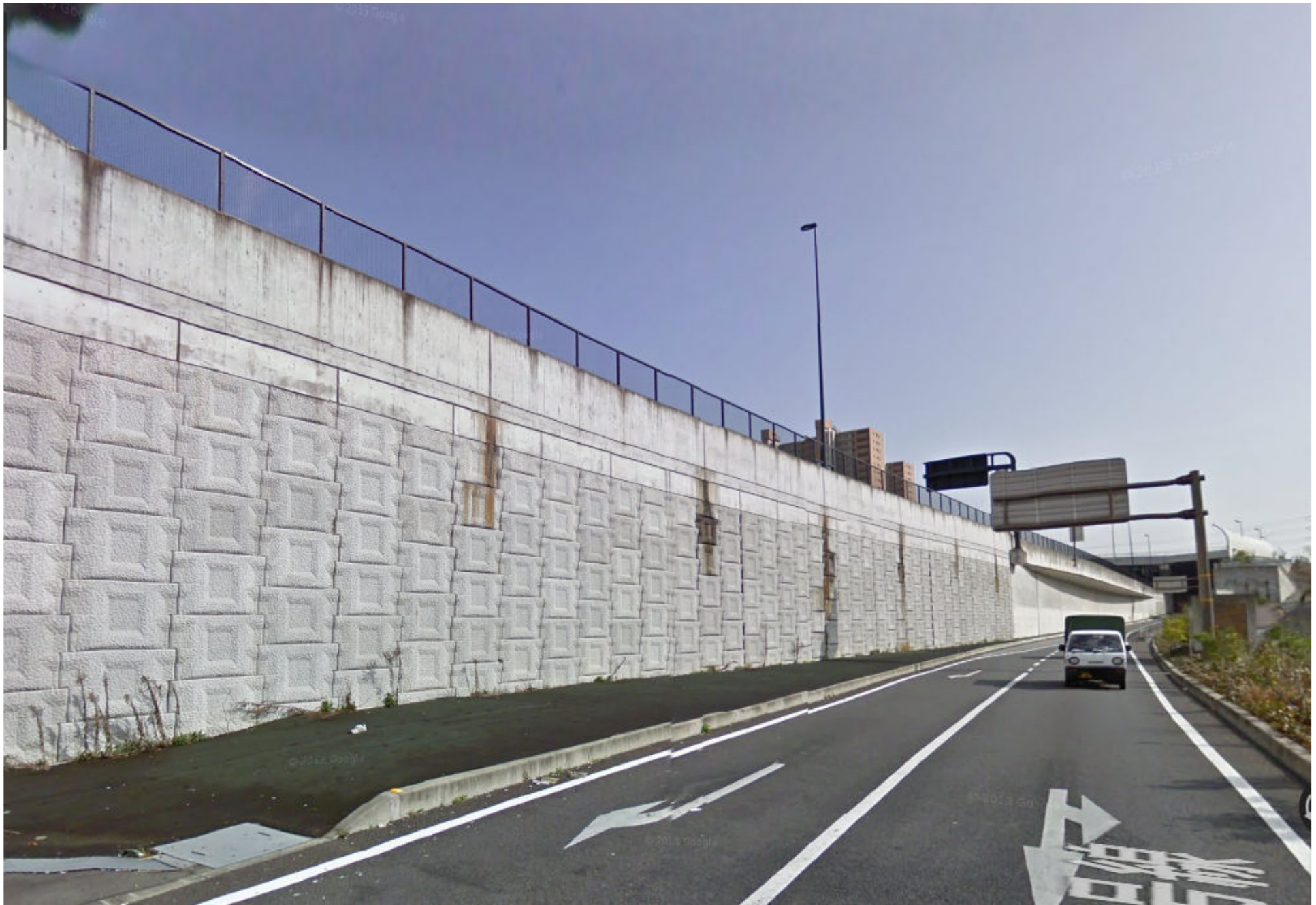
多数アンカー工法（大阪府 国道1号線）
