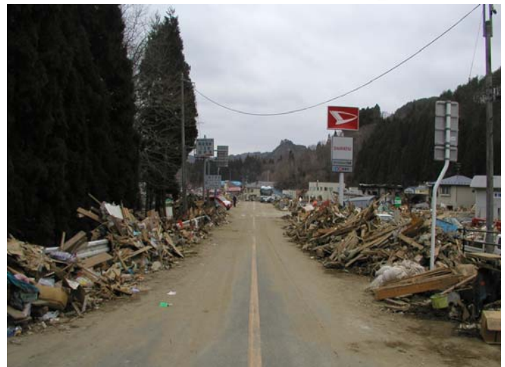
津波により災害を受けた国道の啓開完了
