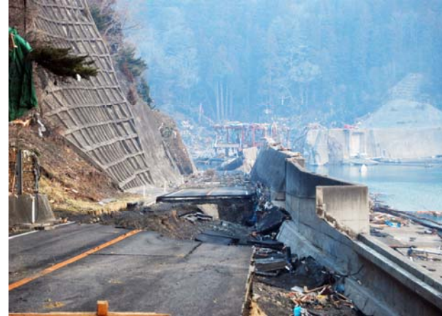
路面の崩落状況(岩手県釜石市)
