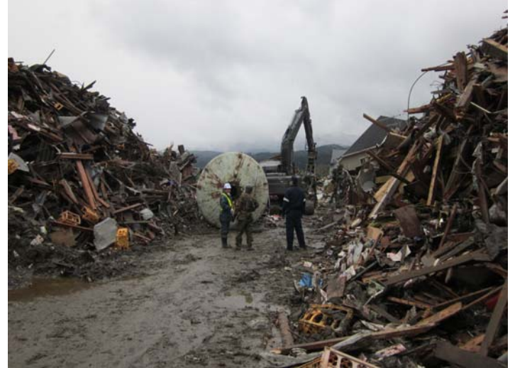
津波により災害を受けた国道の啓開完了 (H23.3.16撮影)
