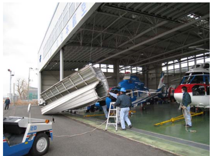
(写真) 地震で壊れた格納庫シャッターを撤去
