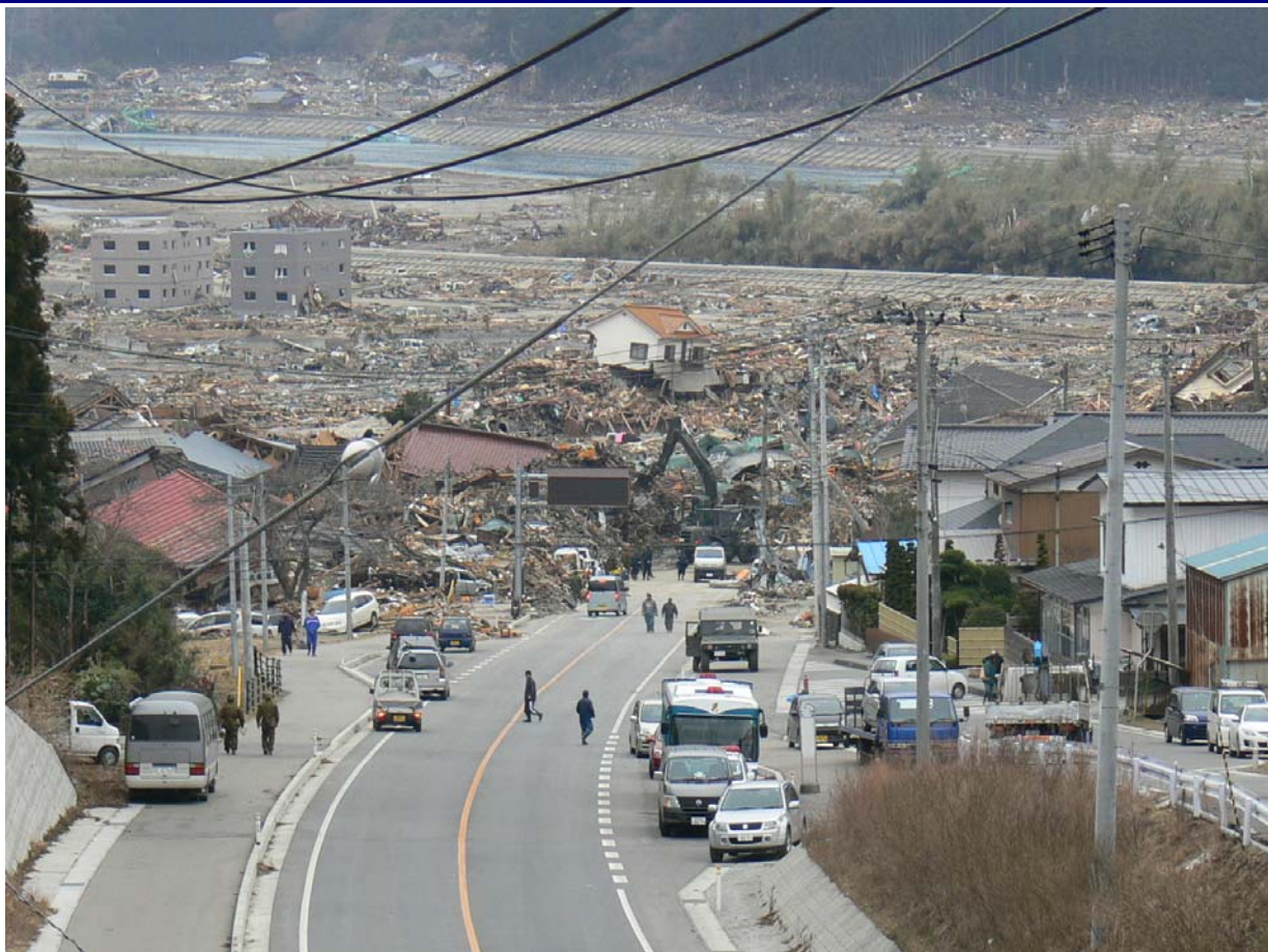
りくせんたかた 陸前高田市国道340号啓開中
