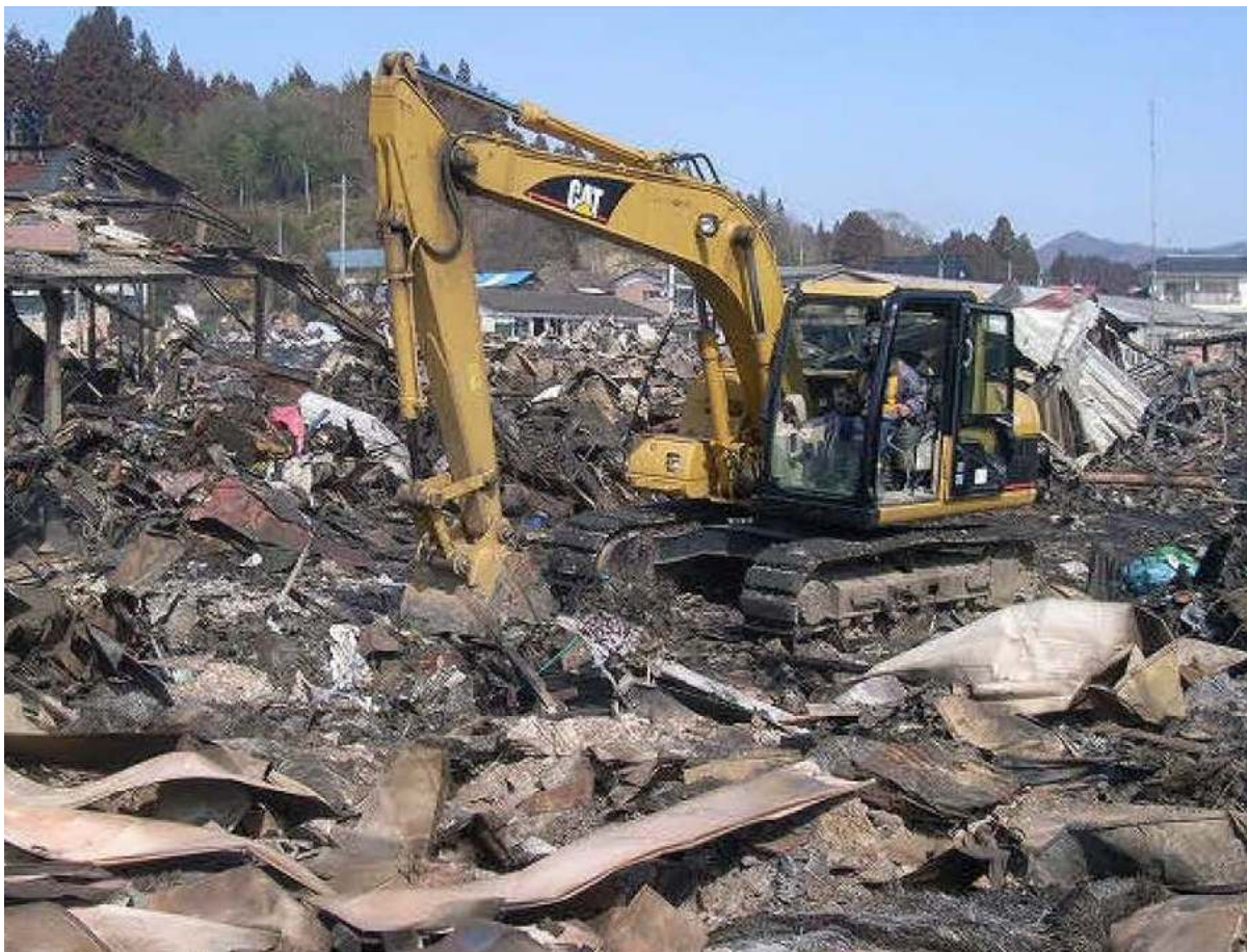
けせんぬま ししおり ・国道45号(宮城県内)の啓開作業中(気仙沼市鹿折地区を撮影) 21
