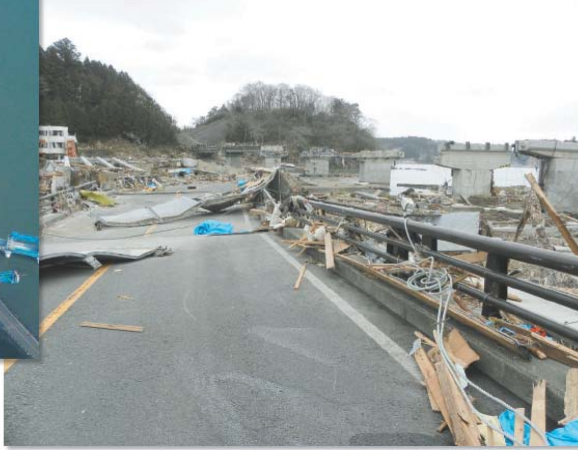
歌津大橋 落橋状況(宮城県南三陸町)
