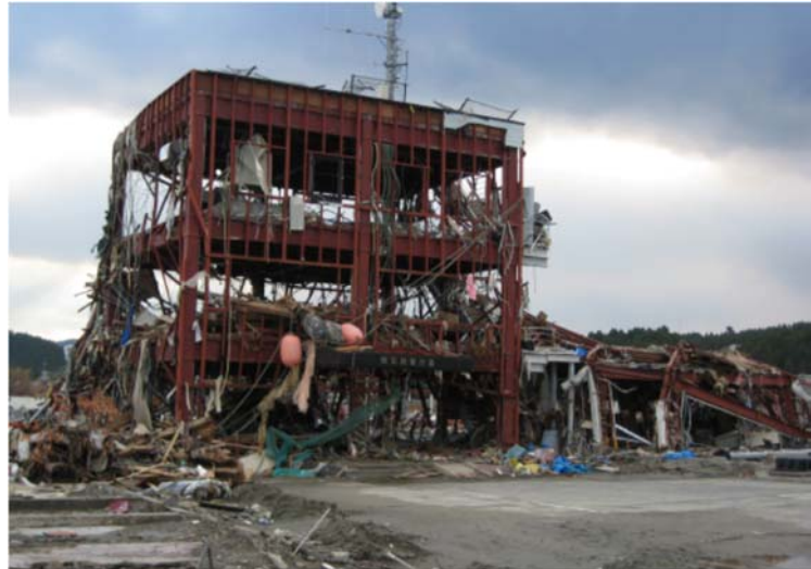
被災後の南三陸町防災対策庁舎
