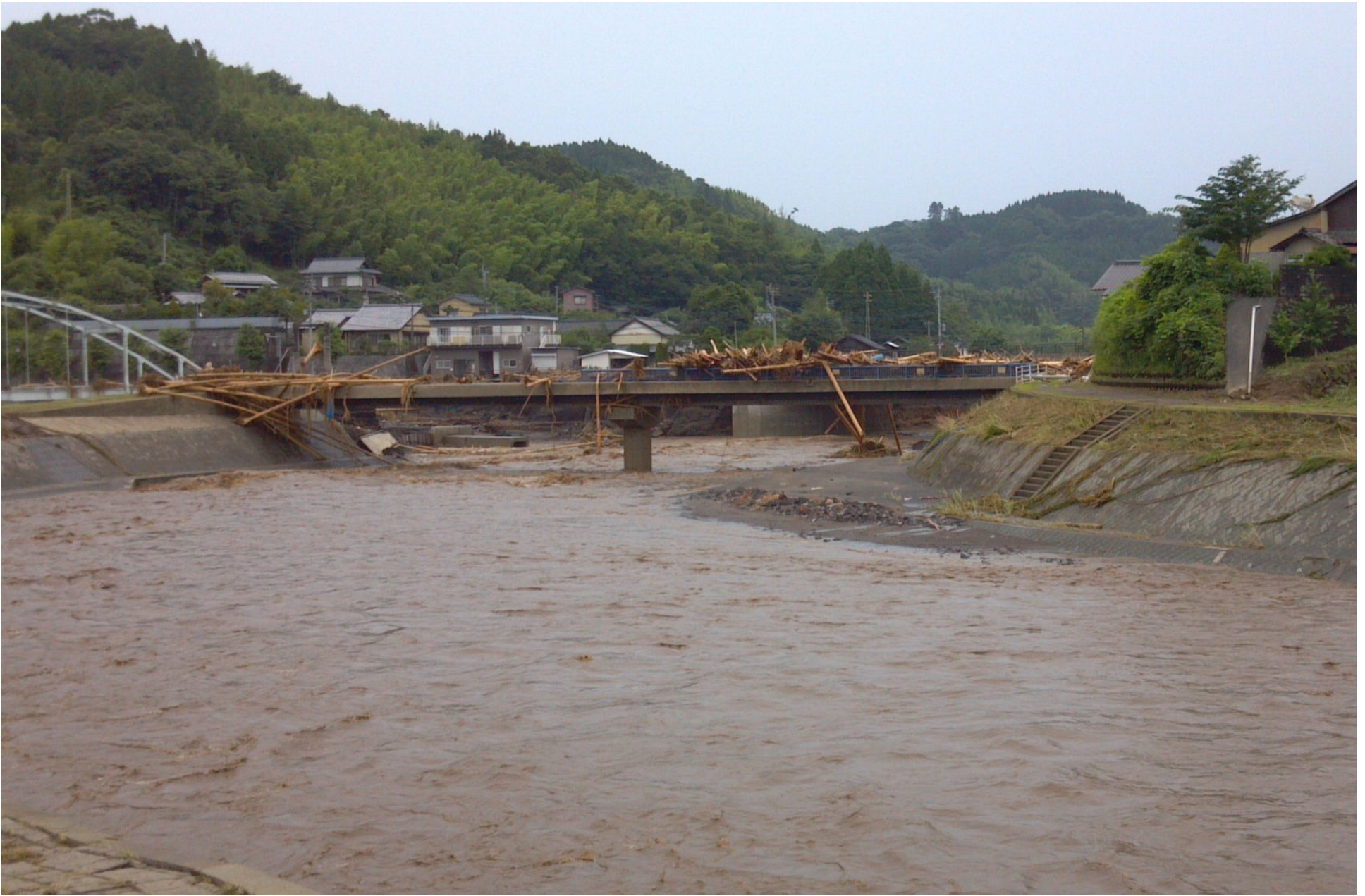
被災後の阿蔵新橋（湾曲部に位置し、橋桁も低い） 18
