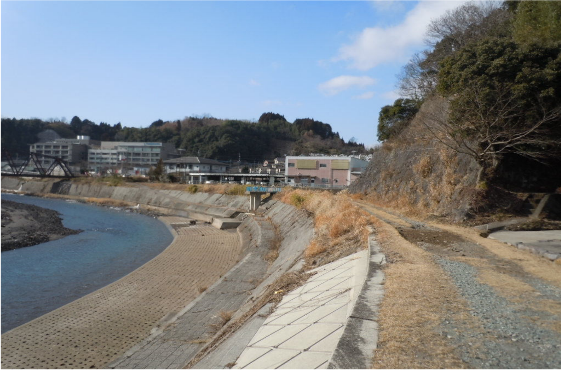
越水した堤防部分
