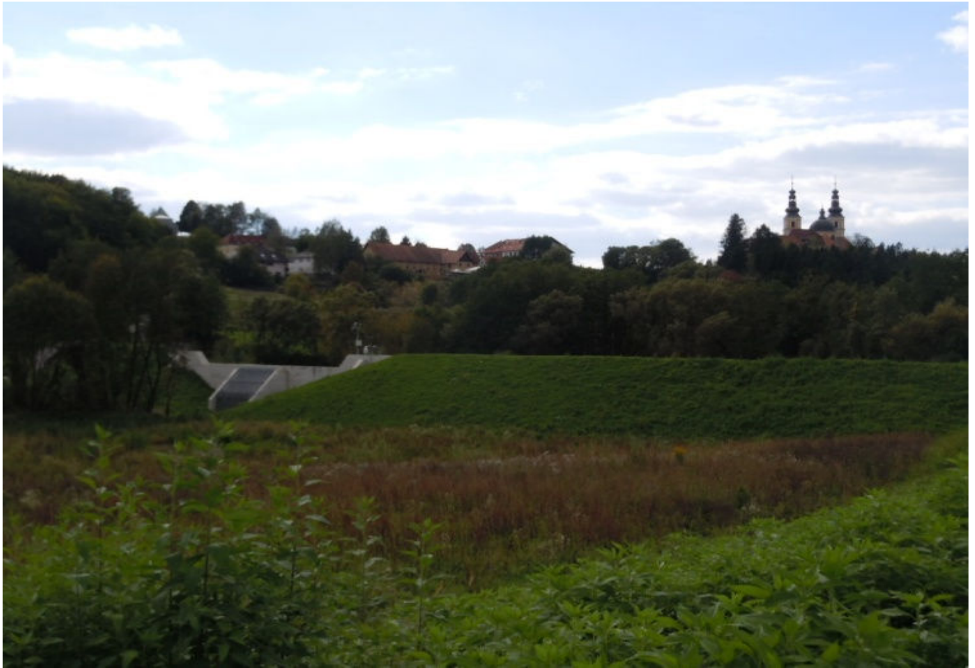
ダム貯水池側から見たダム堤体
