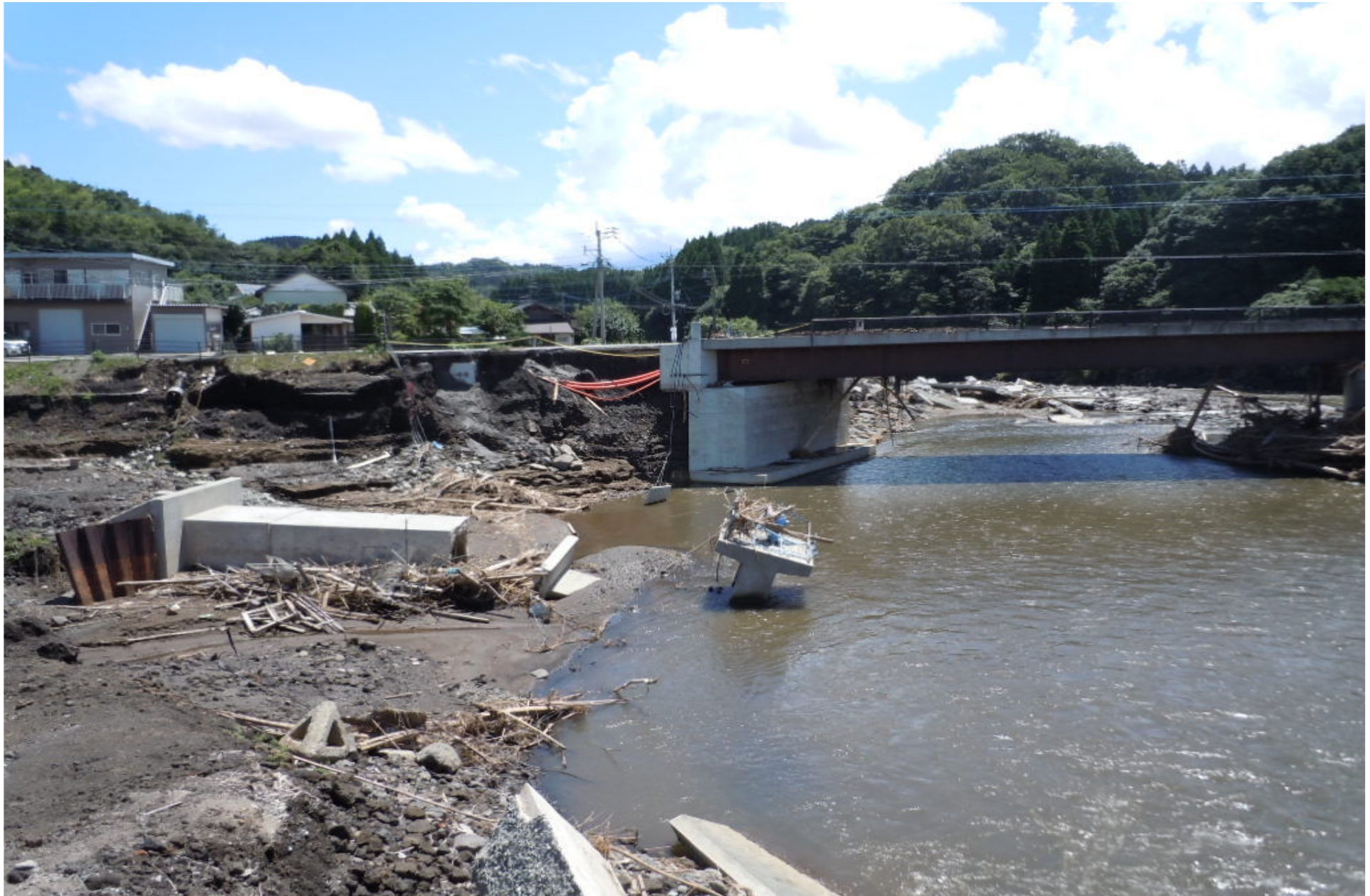
湾曲部の水衝部にせり出す橋台、前に倒れた樋門と堤防 21
