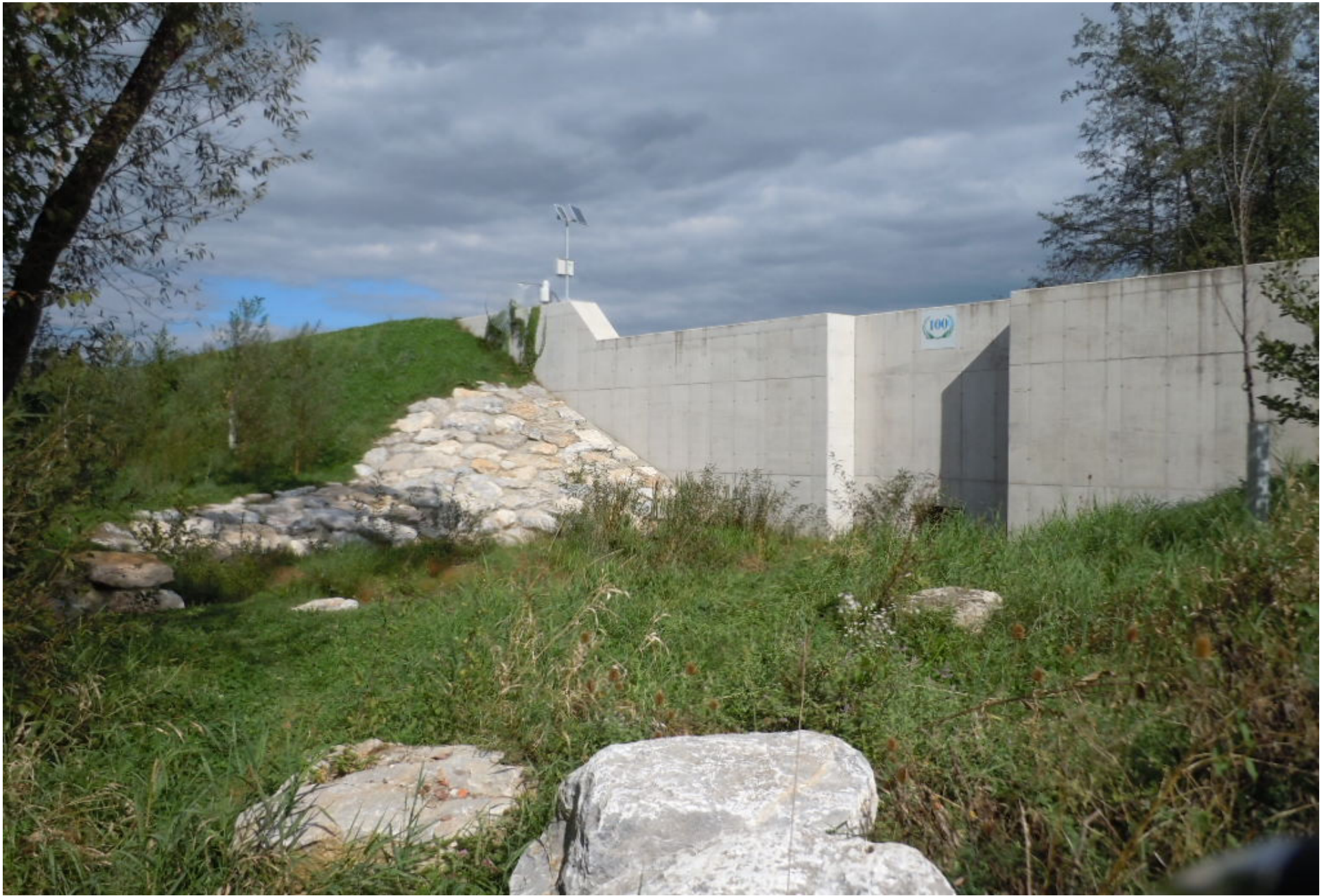
比較的新しい流水型ダム(下流側)
