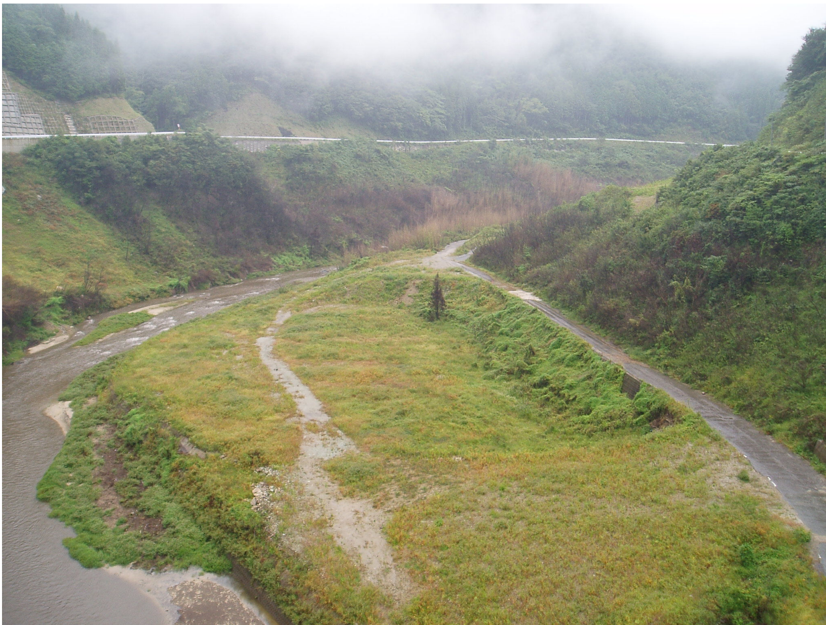
益田川ダム上流側（ダム湖側）の河川へのアクセス道路 81
