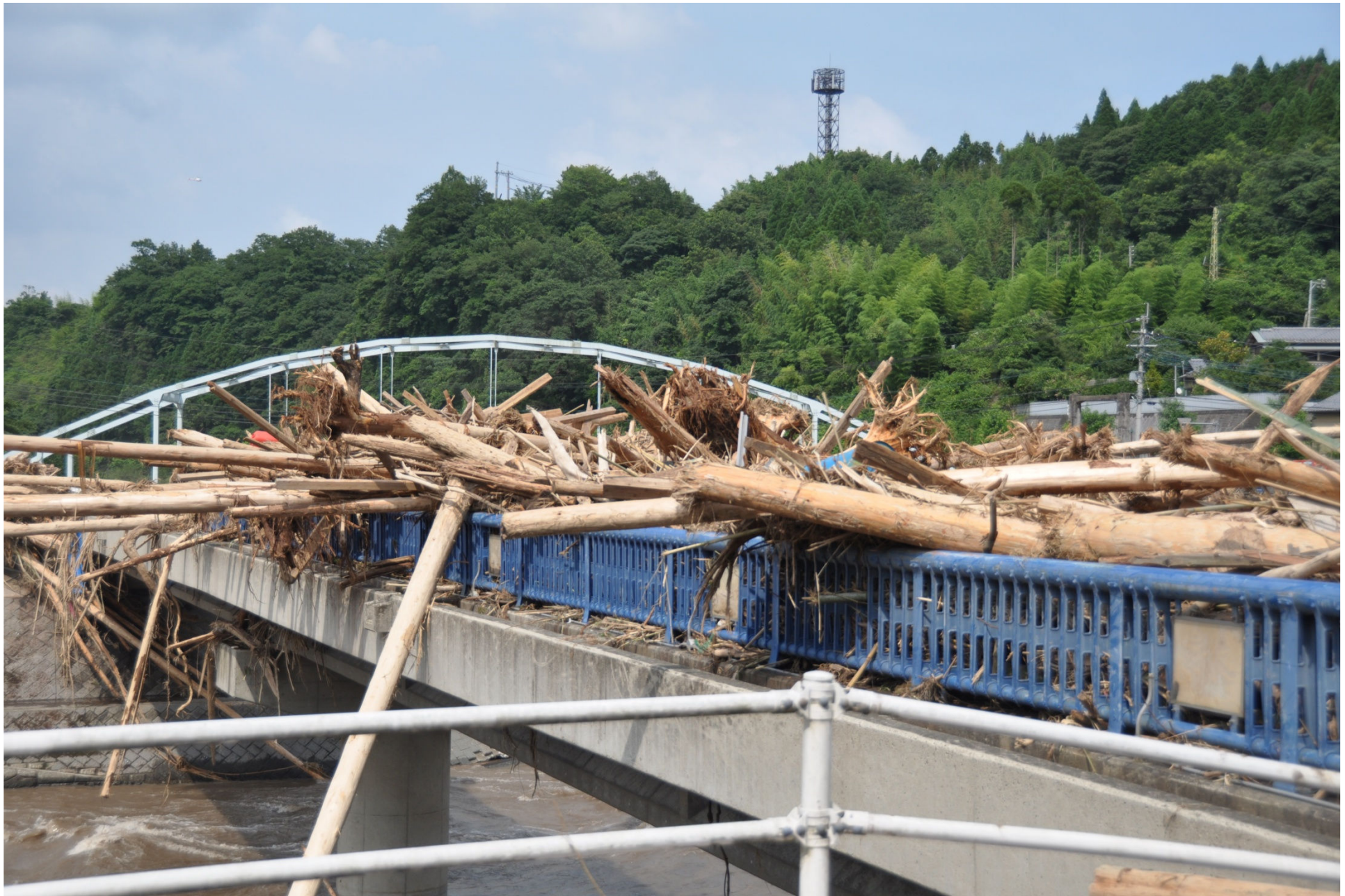
越水部分下流の阿蔵新橋に集積した大量の流木
