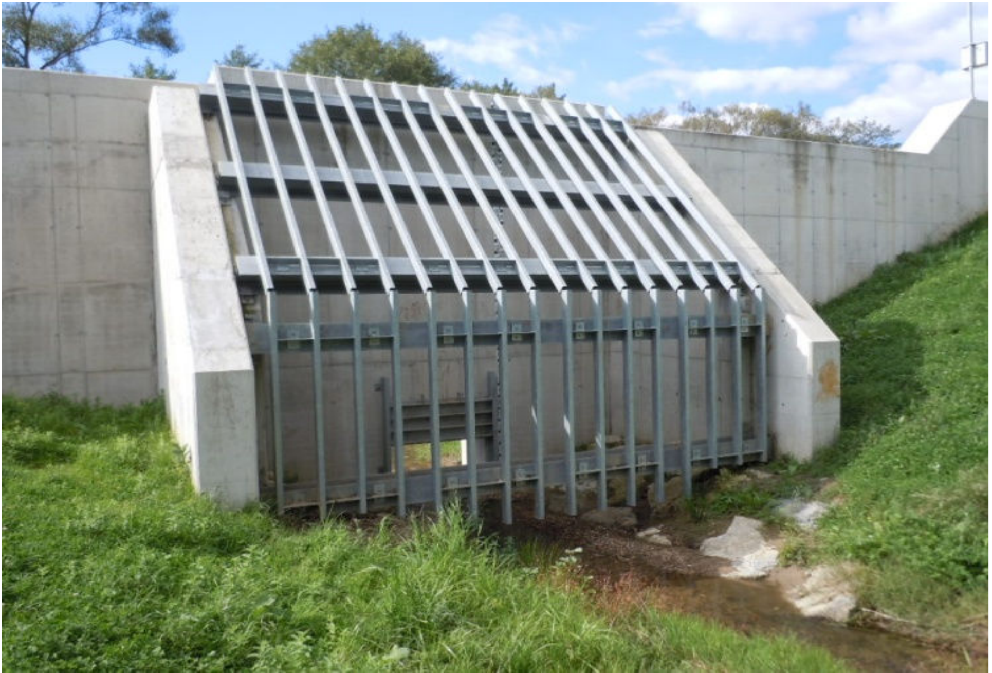
常用洪水吐き(上流側から見た)
