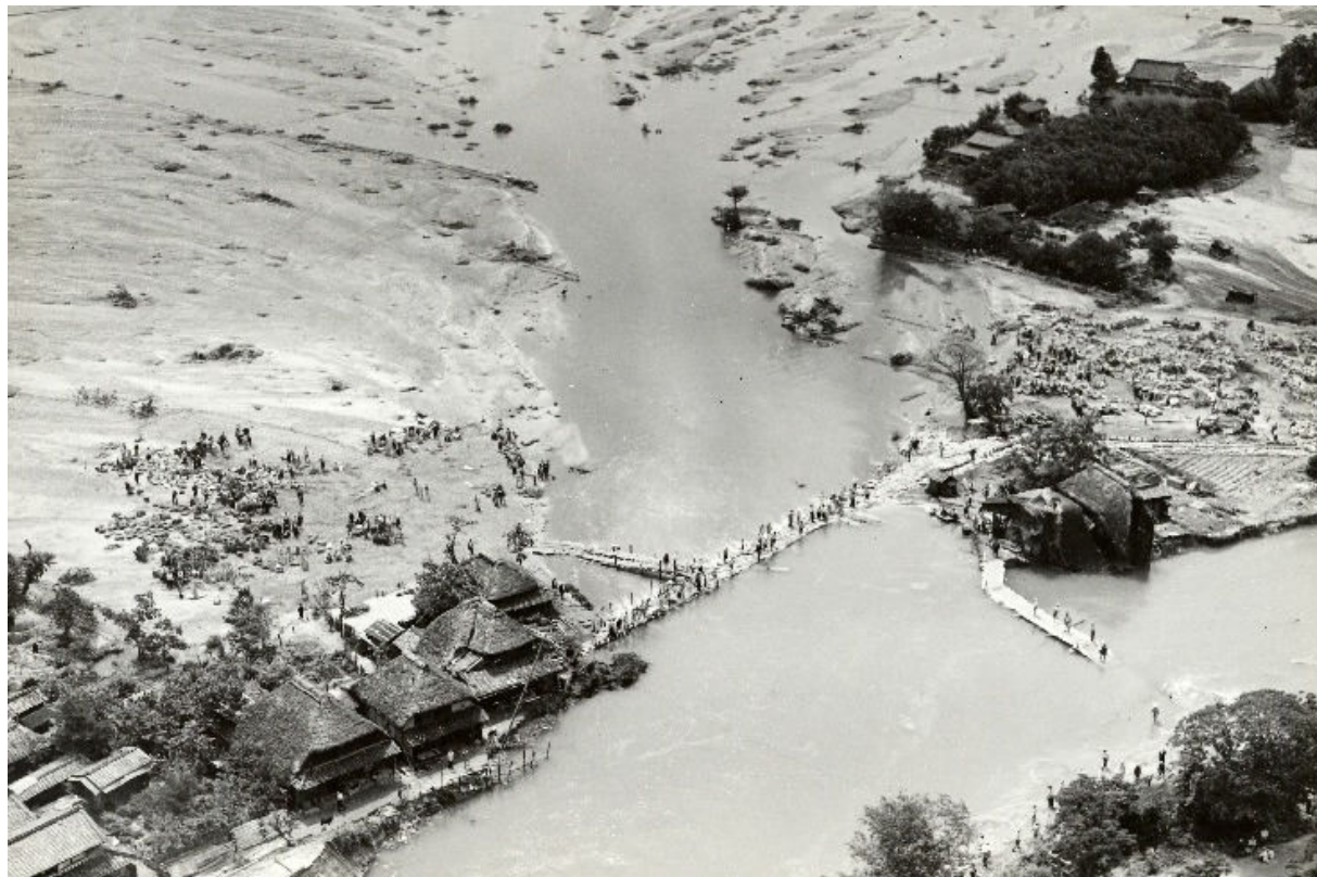
決壊した城原川堤防
