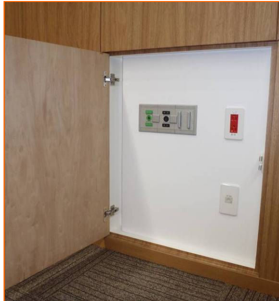
医療ガス（多目的ホール）
