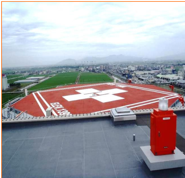
屋上ヘリポート
