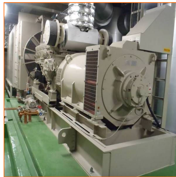
非常用発電機
