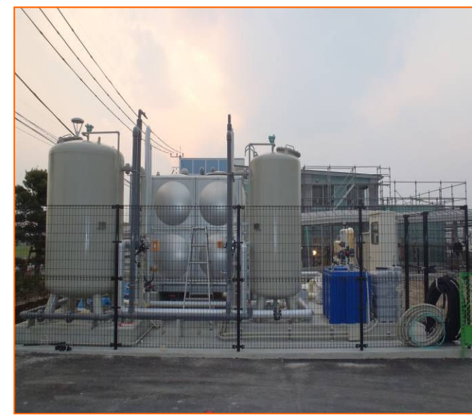
井水濾過装置
