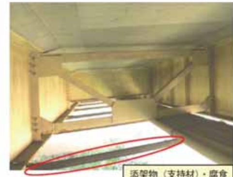
添架物(支持材)・腐食
