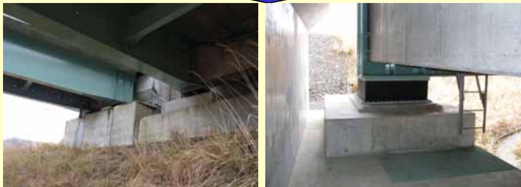
桁端部に空間を確保した事例
