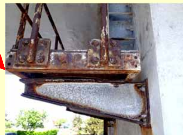
腐食損傷を受けた危険な検査路
