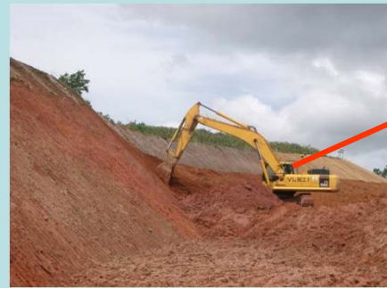
丁張り・補助作業不要
