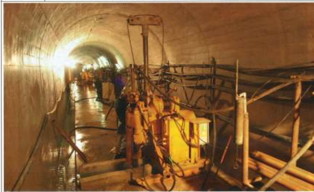
写真 6 カーテングラウチング (右岸リムグラウトトンネル)
