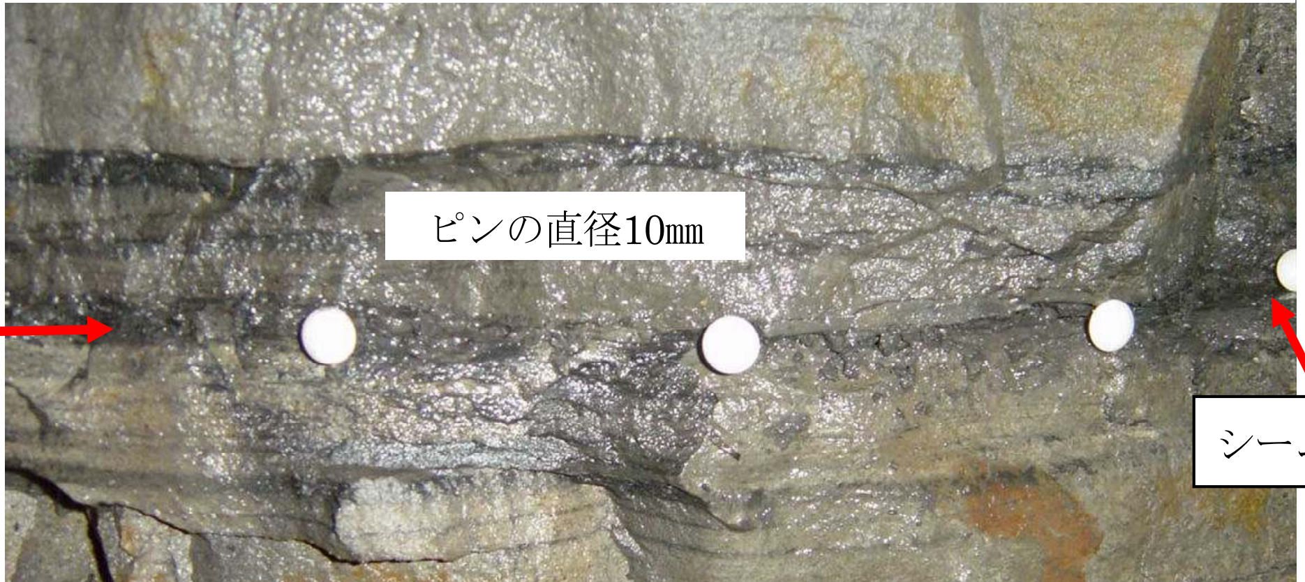
右岸側の調査横坑内壁における低角度シームの状況写真
