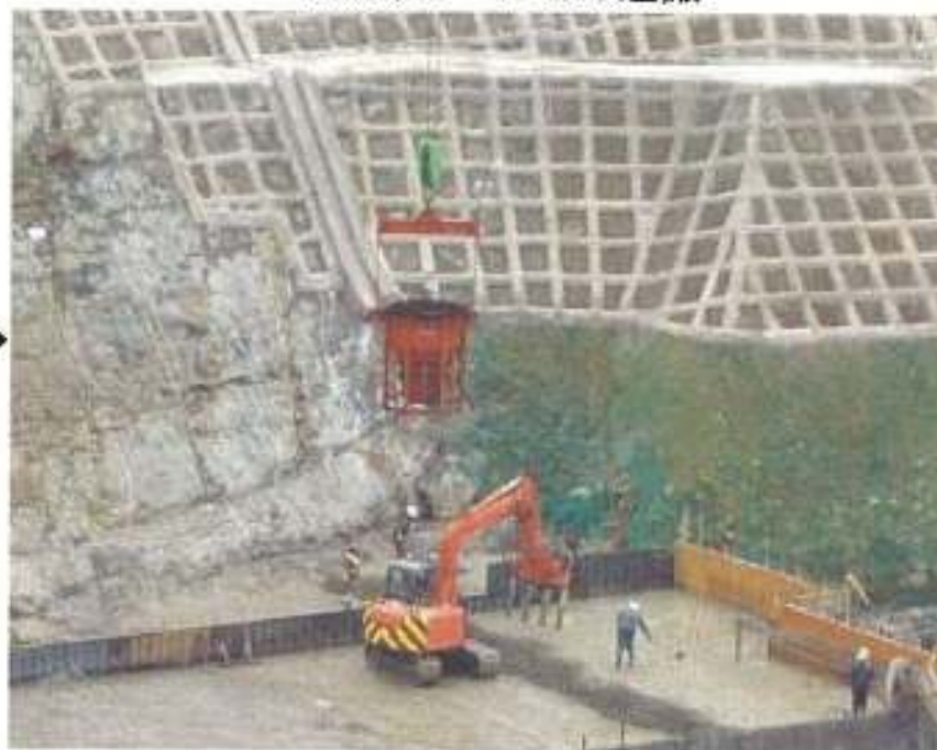
300tクレーンでの運搬
