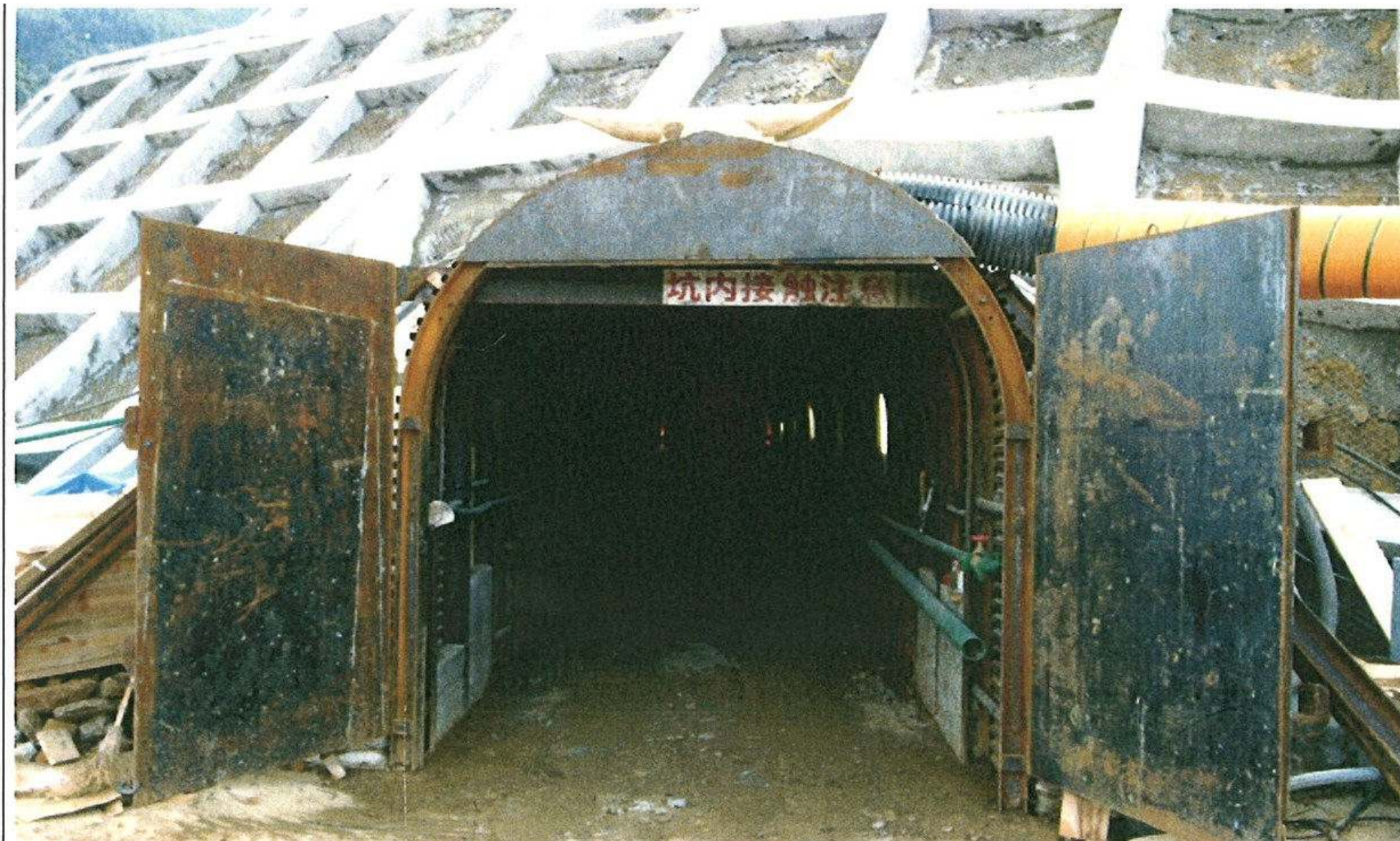
左岸側 リムグラウト トンネル施工状況 (平成20年12月25日)
