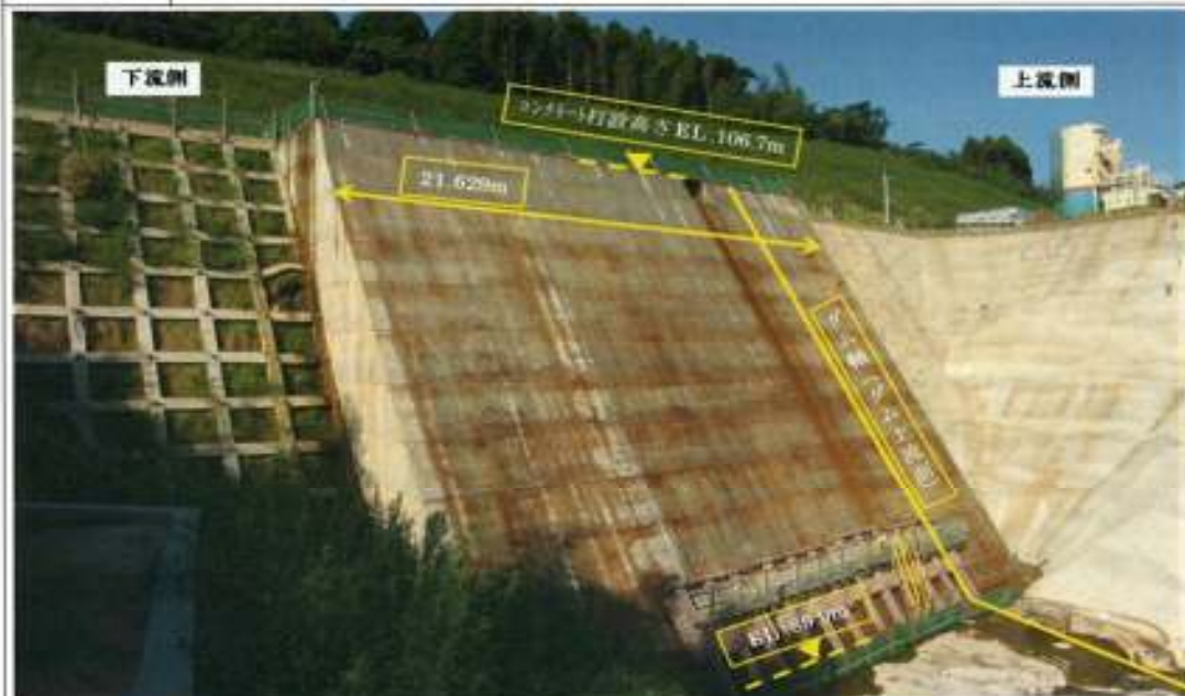
写真 5 造成アバットメント (右岸)
