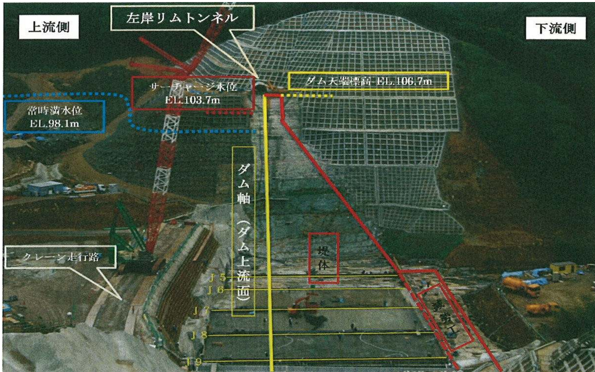
打設 初期の状況 (平成20年12月25日)
