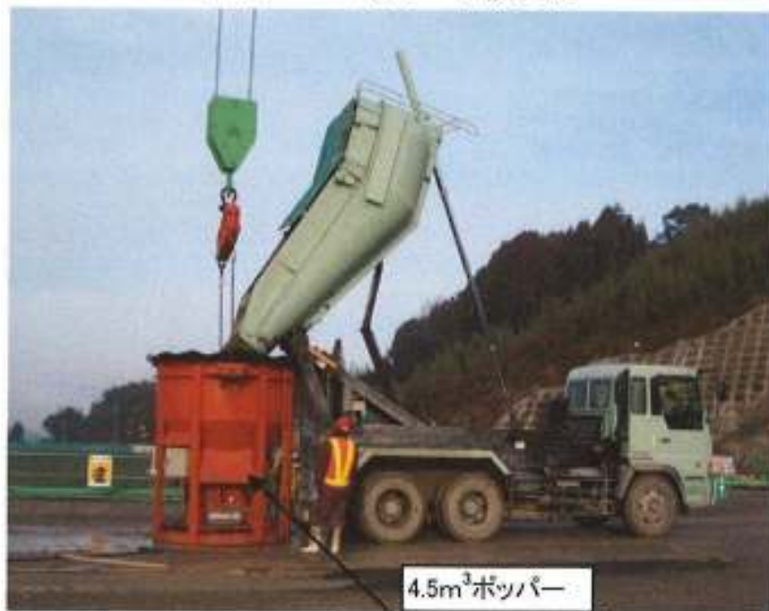
パケットへコンクリート積替え
