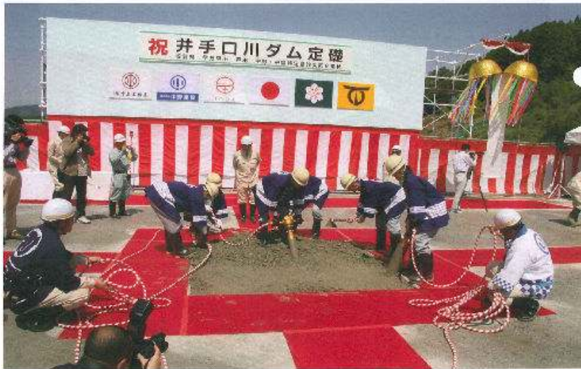
コンクリート新築
