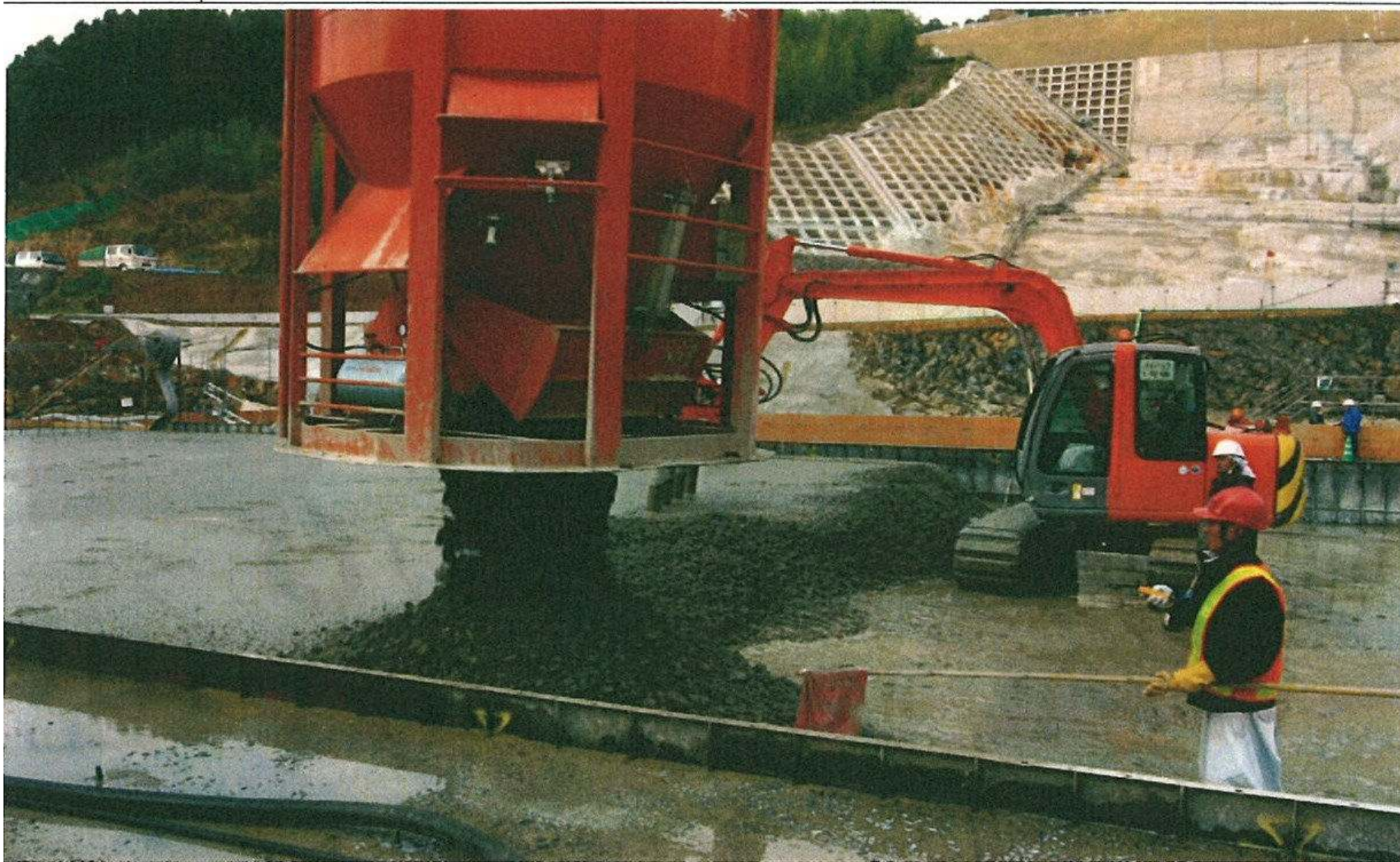
初期の打設状況 (平成20年12月25日)
