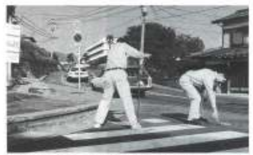
8月25日～26日 上水道12時間断水開始。市職員が配水管のバルブの開閉作業を行ないました。
