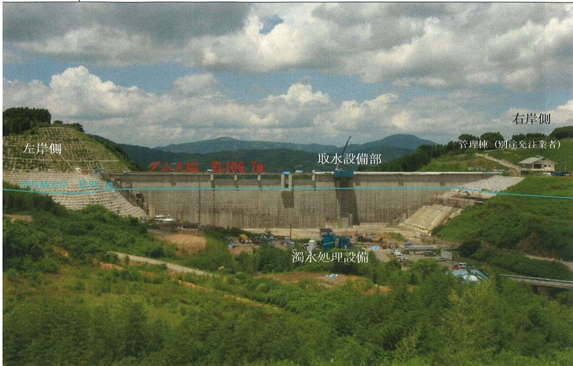
写真 1 | 上流側からダムサイトを望む
