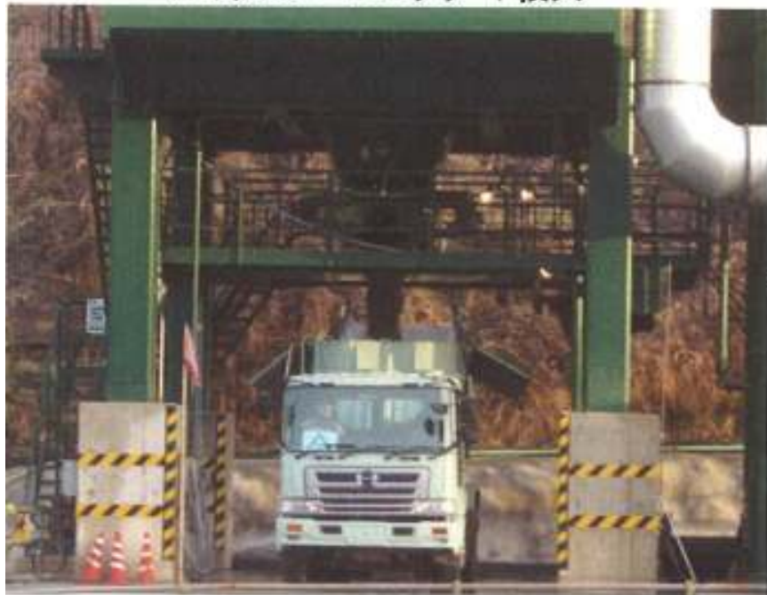
パケットへコンクリート積替え
