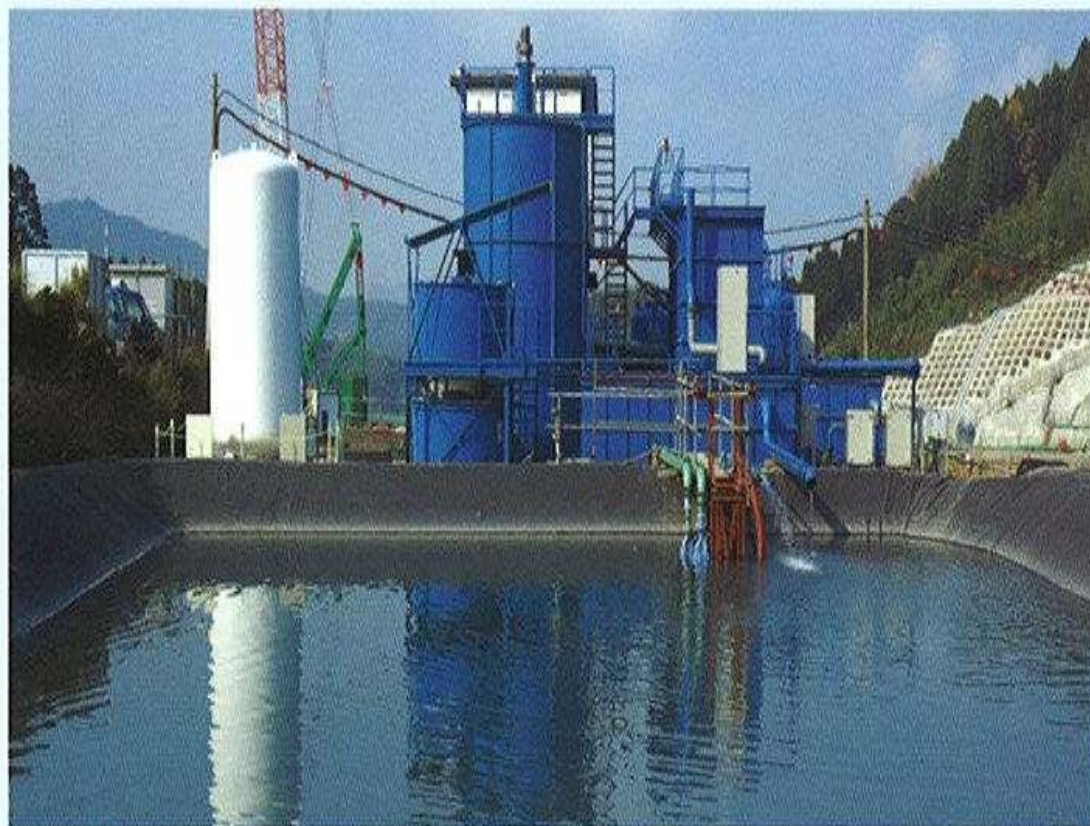
▲濁水処理プラント（処理能力150t/h）
