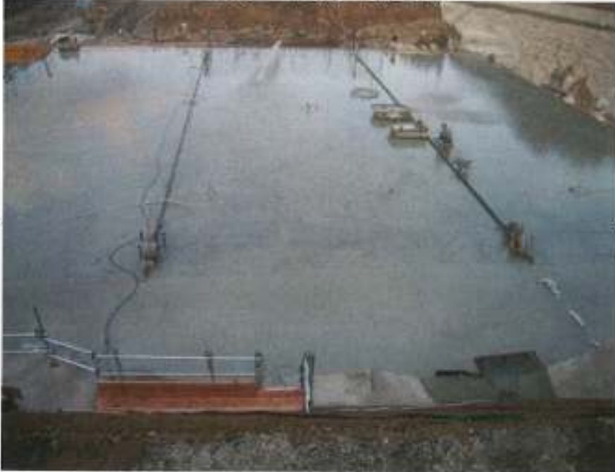
コンクリート養生(湛水)
