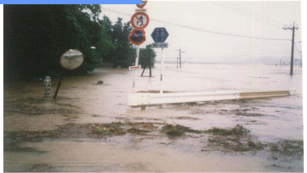
主要地方道相知山内線浸水状況 H2. 7. 2
