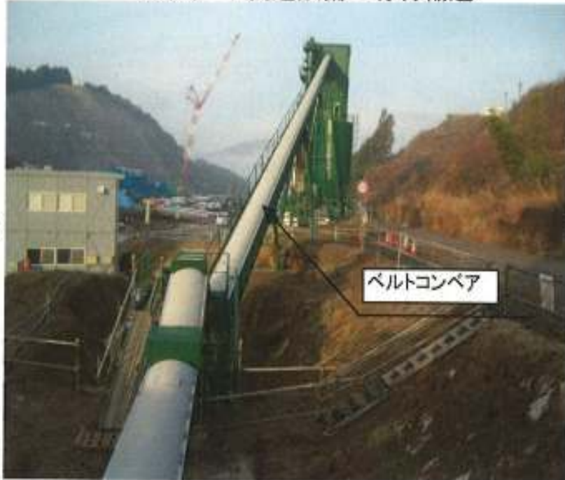
コンクリート製造設備へ骨材輸送
