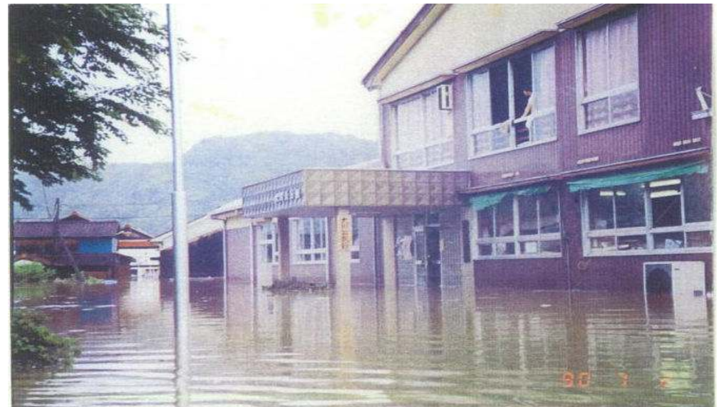
旧大川公民館浸水状況 H2. 7. 2
