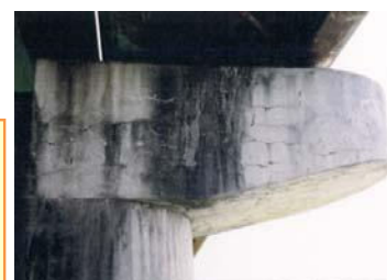
橋脚部分のひび割れ
