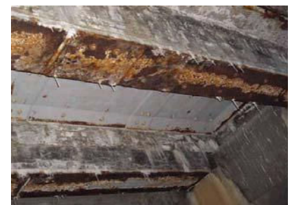
漏水状況(つらら)
