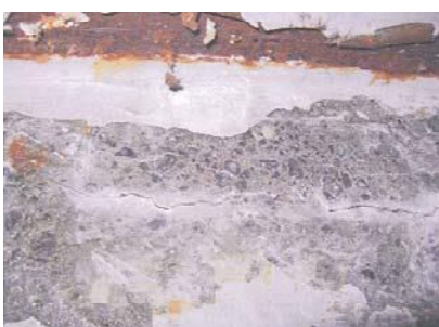
主桁側面の水平方向クラック
