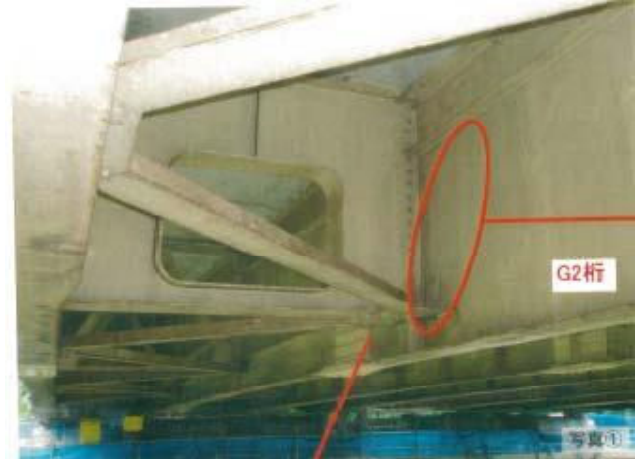
亀裂の状況(内側) CAESAR FIVE
