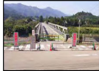
・劣化による橋脚部のコンクリート欠落のため、路面段差が発生し、全面規制実施中。
