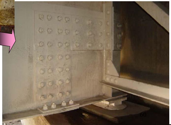
支承周りの切除・新規部材への交換
