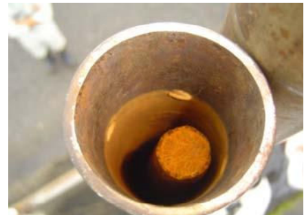
破断吊り材の保護管内部の状況
