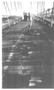
破断したケーブルにより破損した歩道部 出典:New York Times (1984年10月8日)
