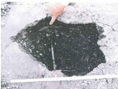
抜け落ち箇所以外での床版の土砂化
