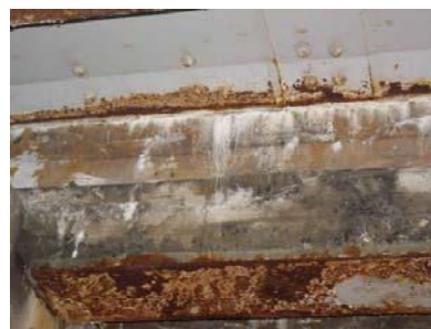
鋼板端部からの漏水
