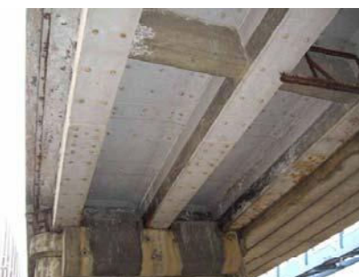
比較的健全な状態の箇所
