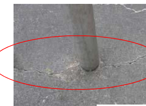
関連部位の損傷
