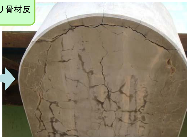
橋脚はり部のひび割れ状況
