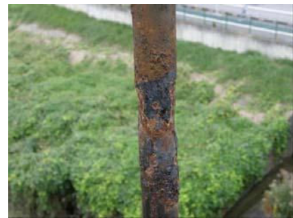
破断部以外の腐食
