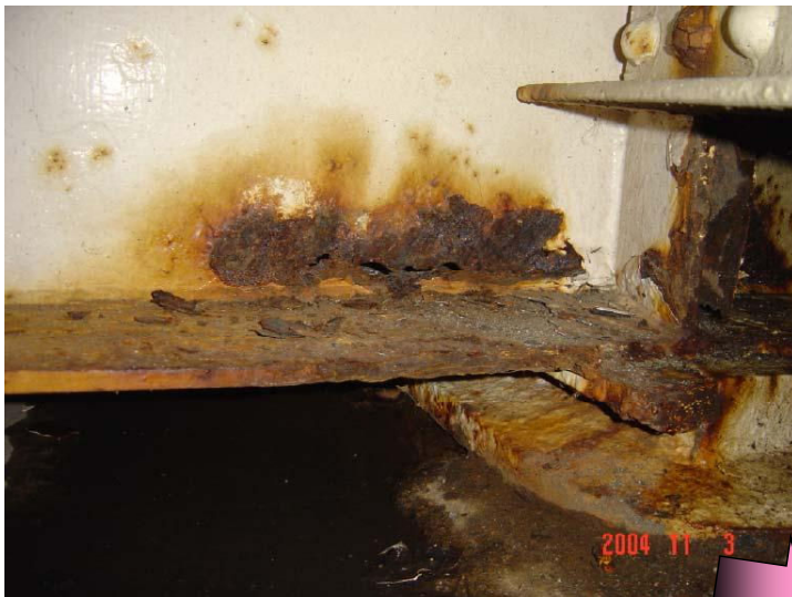
支承周りの切除・新規部材への交換
