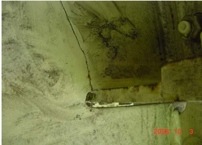
主桁亀裂位置(外側)
