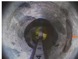
鉛直鉄筋 部分損傷 丸鋼φ6
