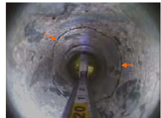
ひび割れ 幅0.2mm
