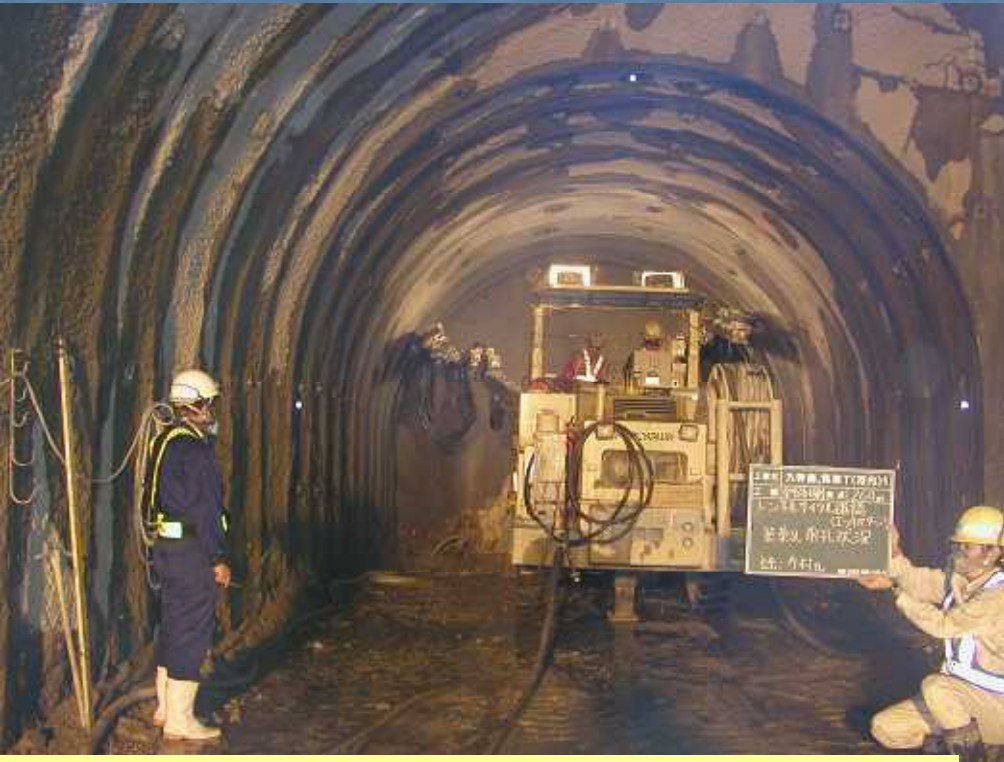
斜坑内掘削中
