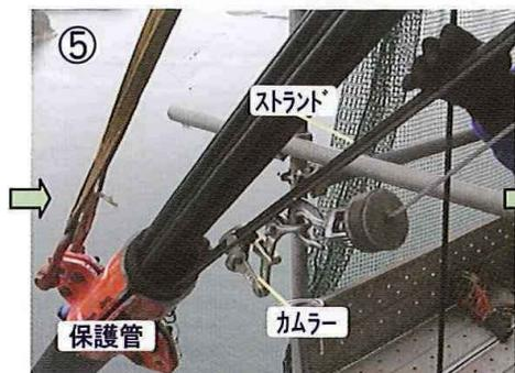
塔外に上がったストランドは、カメラにより塔外から塔内へ引上げます。
