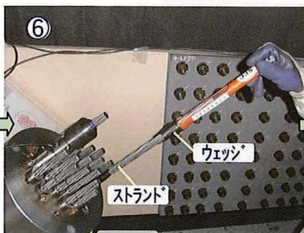
塔内へ引上げられたストランドにウエッジを取付けて定着します。
