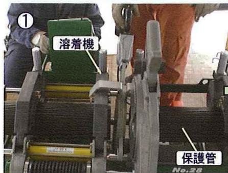
溶着機により保護管を突合せて溶着し、保護管を組立てます。
