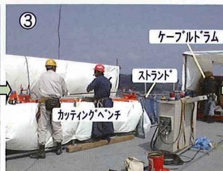
ドラムのストランドを引出し、カッティングベンチ上で被覆の皮剥き・切断します。
