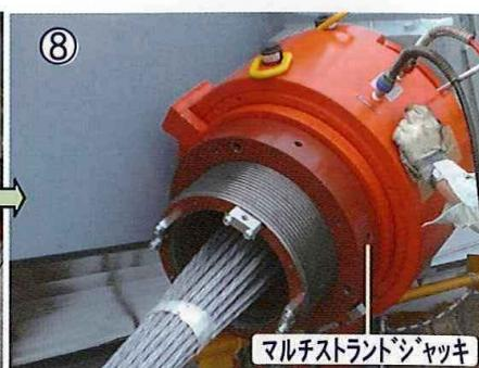
架設後、張力調整はマルチストランドジャッキにより容易に出来ます。
