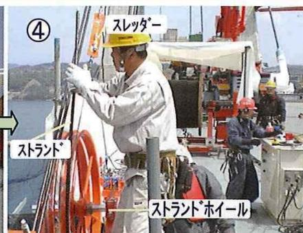
ストランドをスレッターに繋げ、ウィンチにより橋面から塔外作業場に引上げます。
