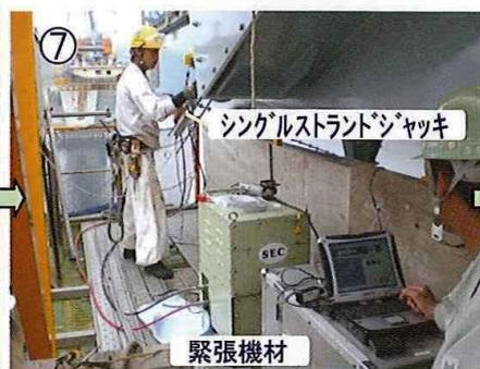
桁側定着部に挿入したストランドに、張力を導入します。
