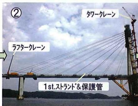
1st.ストランドおよび保護管をタワークレーンとラフタークレーンにより架設します。
