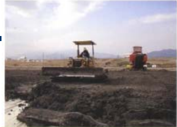
22. セメント改良層敷均し状況
