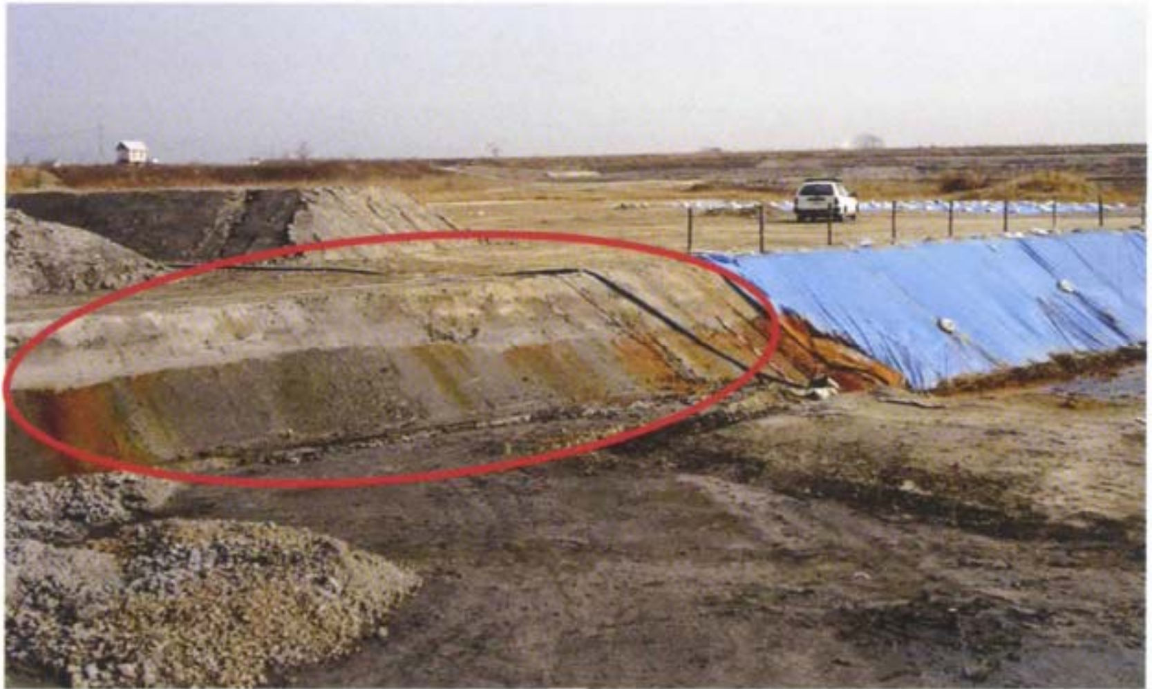
調整池内に湧出する地下水の様子(第2貝塚) 国交省・九地整・佐賀河川総合開発事務所:佐賀導水事業巨勢川調整池～東名遺跡の保存対策～, p.14, 2007.
