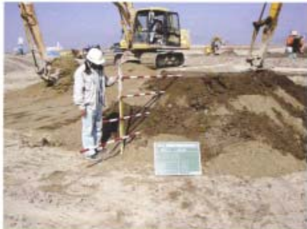
26, 互層状《石灰処理土・砂》敷均し状況
