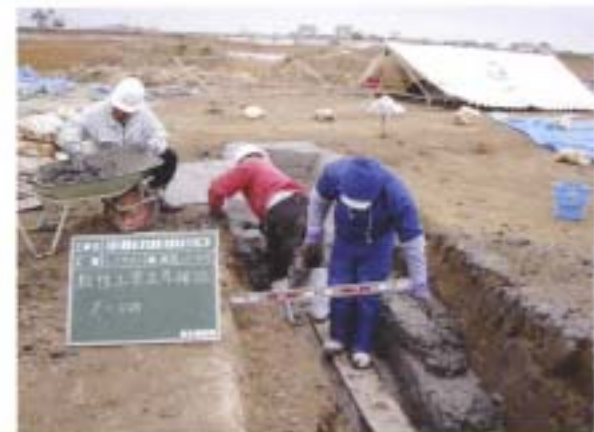
4. トレンチ埋め戻し状況 (粘土塗り立て)
