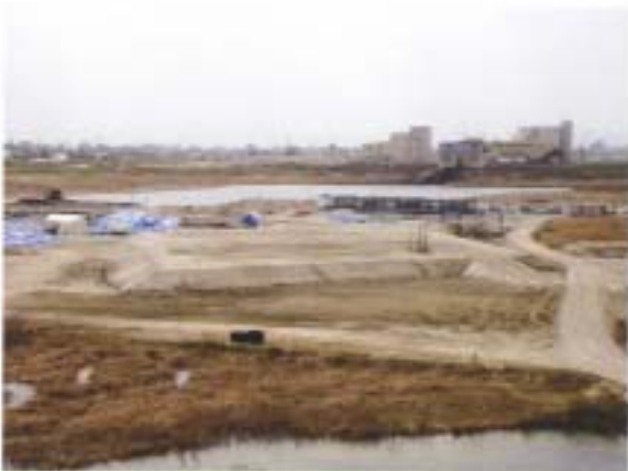
30. キャッピング完成状況 (その1)
