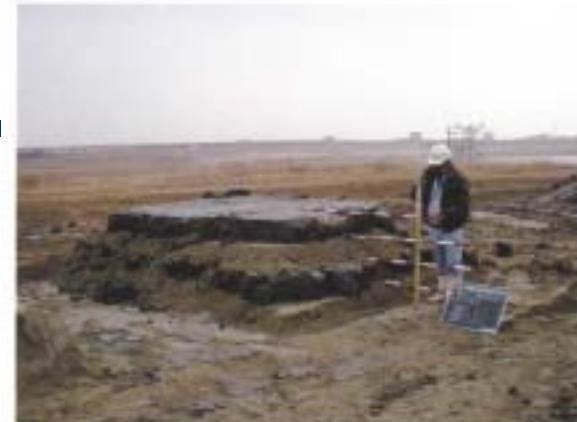
14. 互層状 (粘土・砂) 敷均し状況
