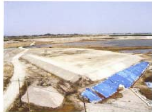
31. キャッピング完成状況 (その2)
