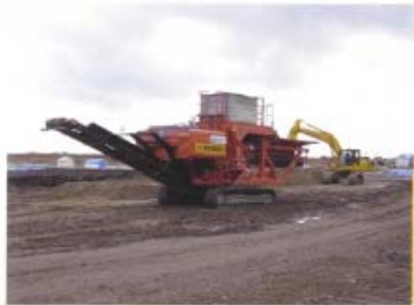
19. 2次混合機械 (自走式土質改良機)
