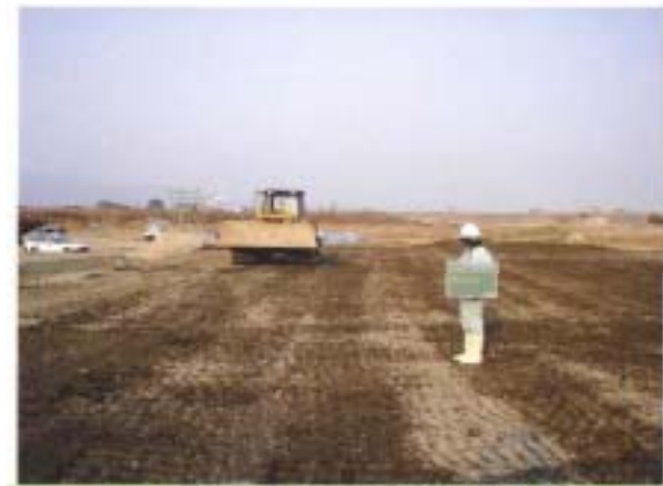
24. セメント転圧状況
