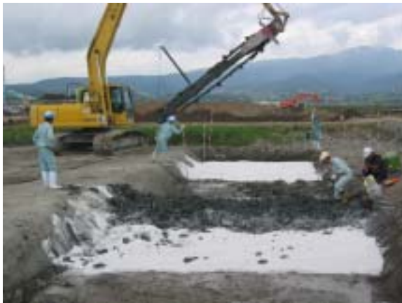
攪拌前の状況
