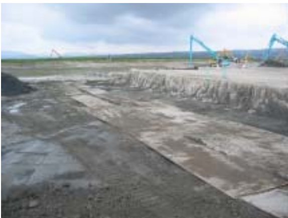
改良28日目以降の開削現場の状況
