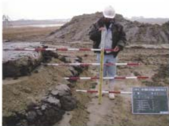
15. 互層状 (粘土・砂) 敷均し状況
