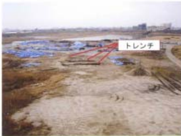
1. 第3貝塚全景 (施工前)
