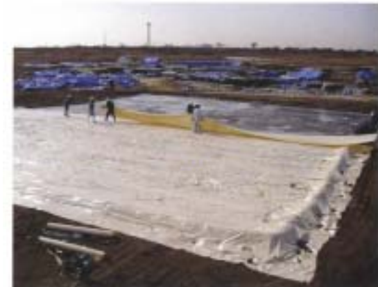
12. 土布シート敷設状況
