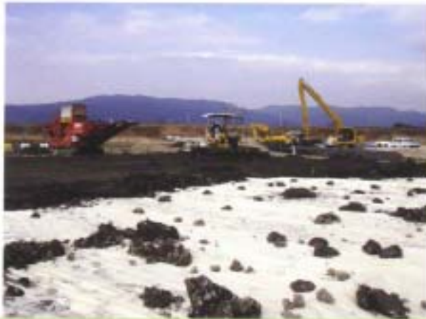
21. セメント改良層敷均し状況
