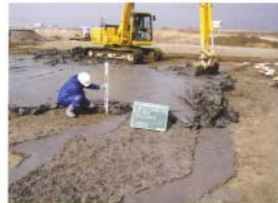
10. 粘性土敷設状況
