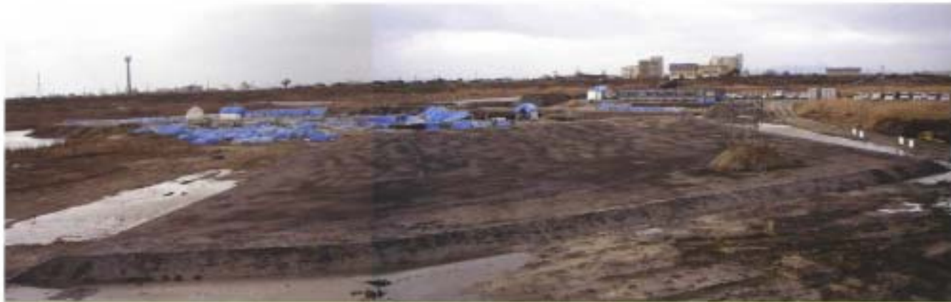
25, セメント改良層完成状況
