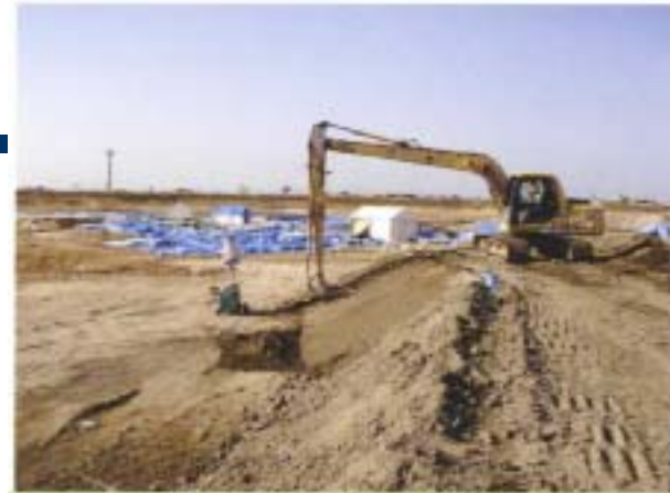
29. 覆土層法面成形状況
