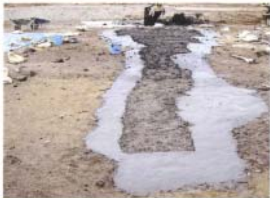
9. トレンチ埋め戻し完了
