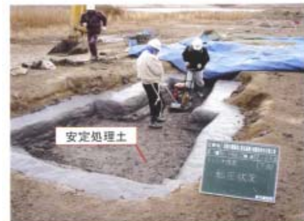
8. トレンチ埋め戻し状況 (安定処理土転圧)
