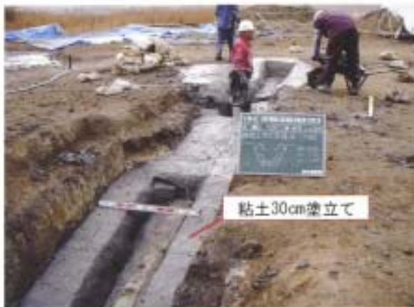
5. トレンチ埋め戻し状況 (粘土塗り立て)
