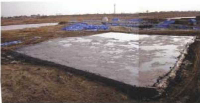
11. 粘性土敷設状況 (全景)
