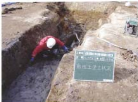
3. トレンチ埋め戻し状況 (粘土塗り立て)
