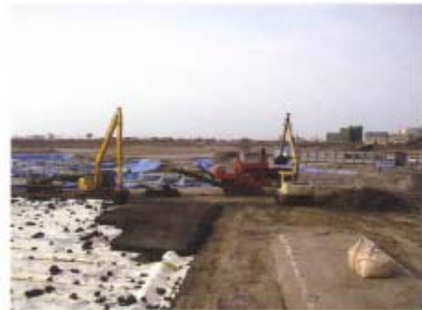
20. セメント改良層敷均し状況
